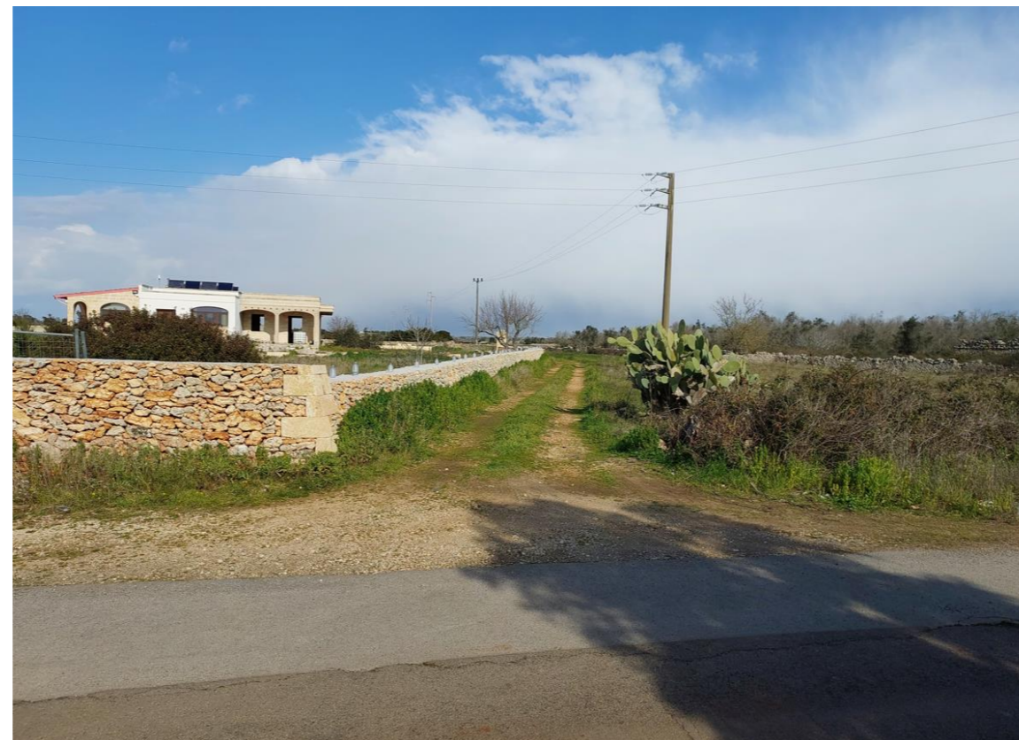
Figura 21. Vista dello svincolo della complanare esistente oggetto di adeguamento.
