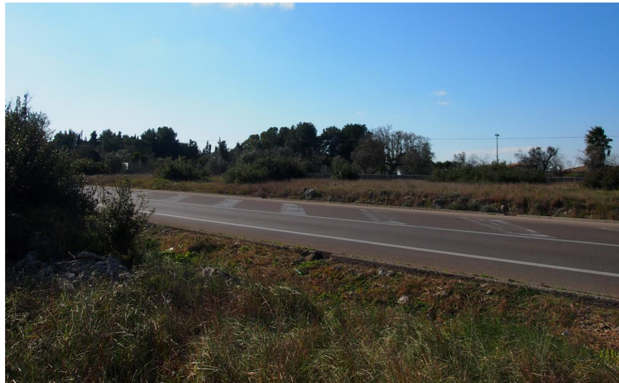
Figura 81. Vista su SS 275 nella configurazione attuale.
