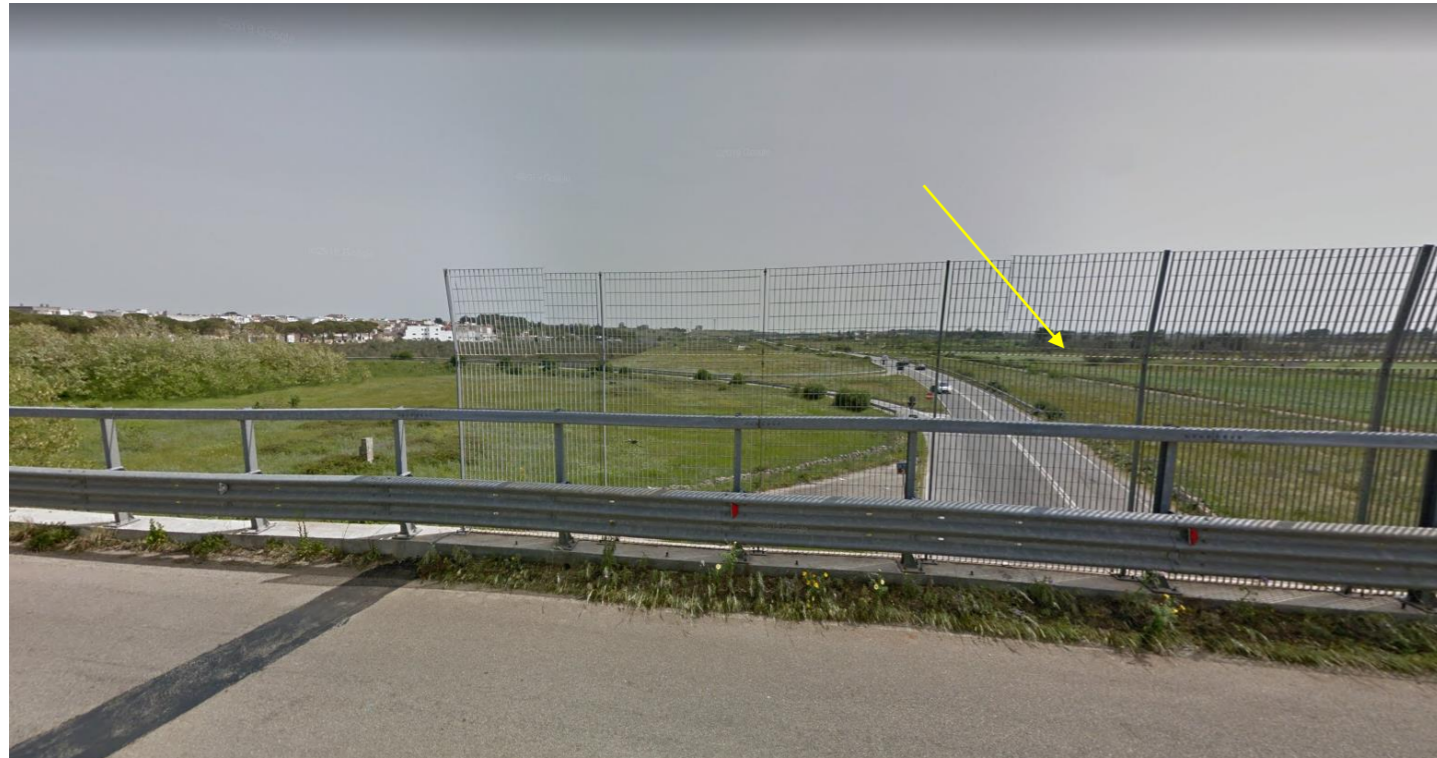
Figura 53. Vista sullo stato di fatto della SS 275 con indicata l'area dove sarà realizzata la vasca oggetto di variante localizzativa.
