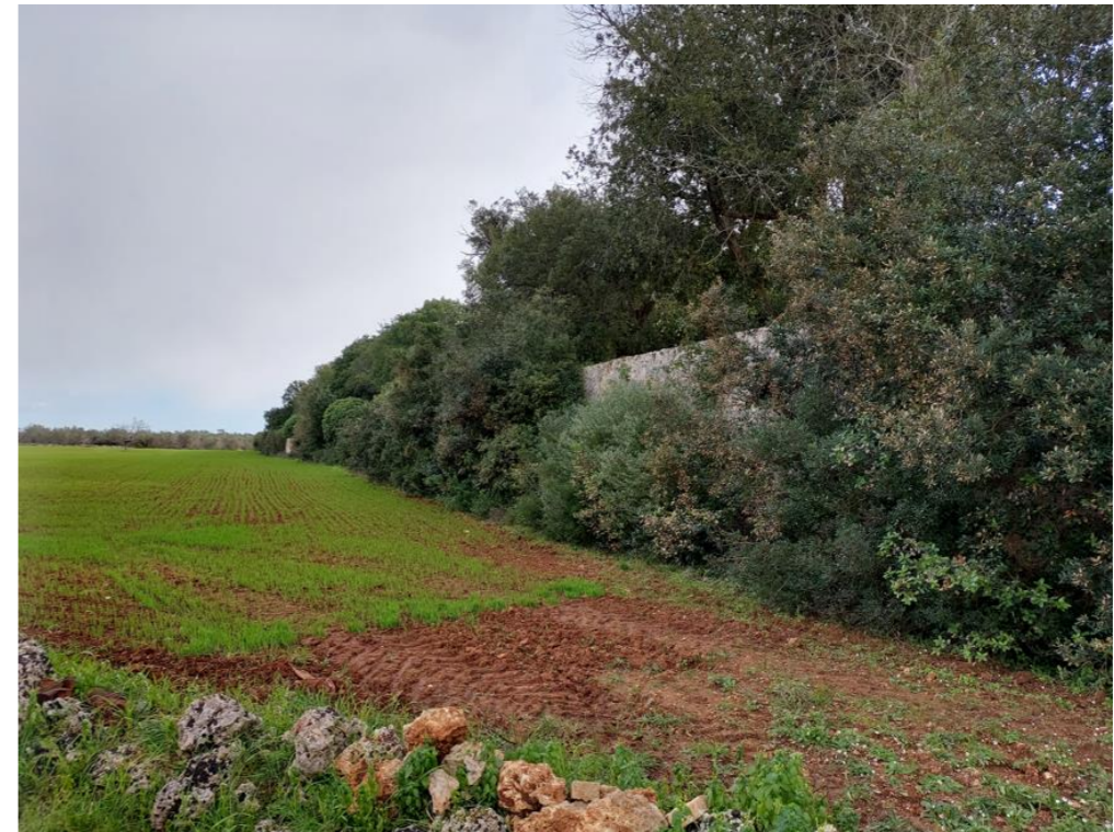
Figura 9. Vista del muro perimetrale Nord della Macchia di Ponente. Foto scattata dal punto in cui la strada perimetrale devia allontanandosi dal Parco.
