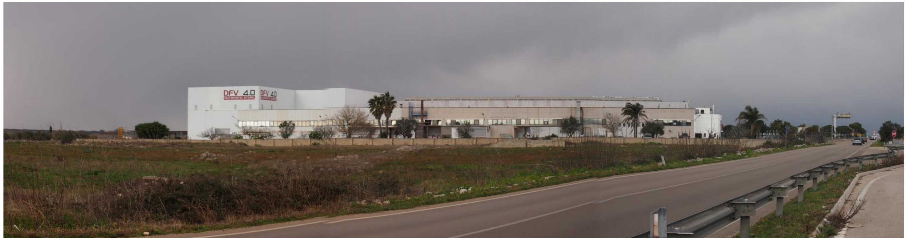
Figura 28. Vista dell'area in cui saranno realizzate le vasche.
