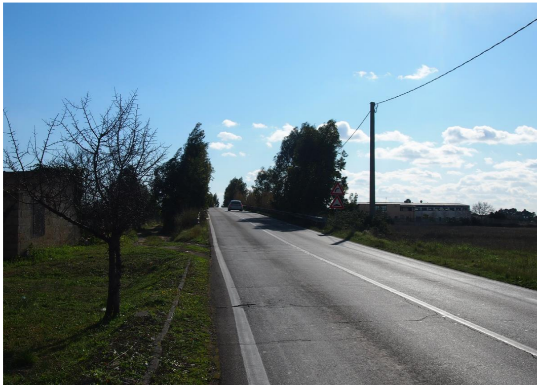
Figura 14. Vista dall'area di sovrappasso attuale che verrà dismessa a seguito della realizzazione della nuova rampa che si innesterà direttamente nella rotonda esistente (freccia gialla nell'immagine seguente).
