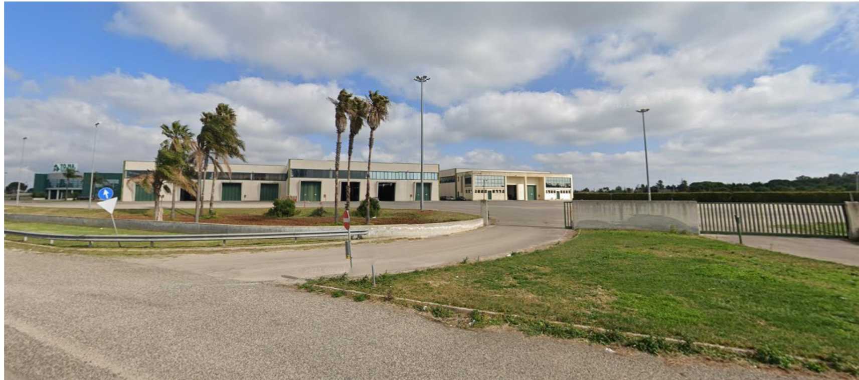
Figura 82. Vista da SS 275 in direzione dell'area in cui si eseguirà la vasca verso settore Nord della stessa.
