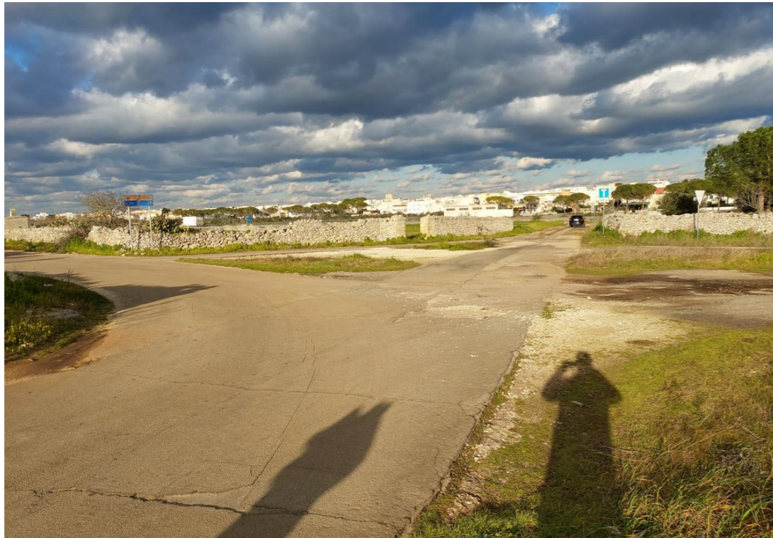
Figura 45. Vista dello svincolo esistente sul quale inizierà la rampa di sovrappasso.
