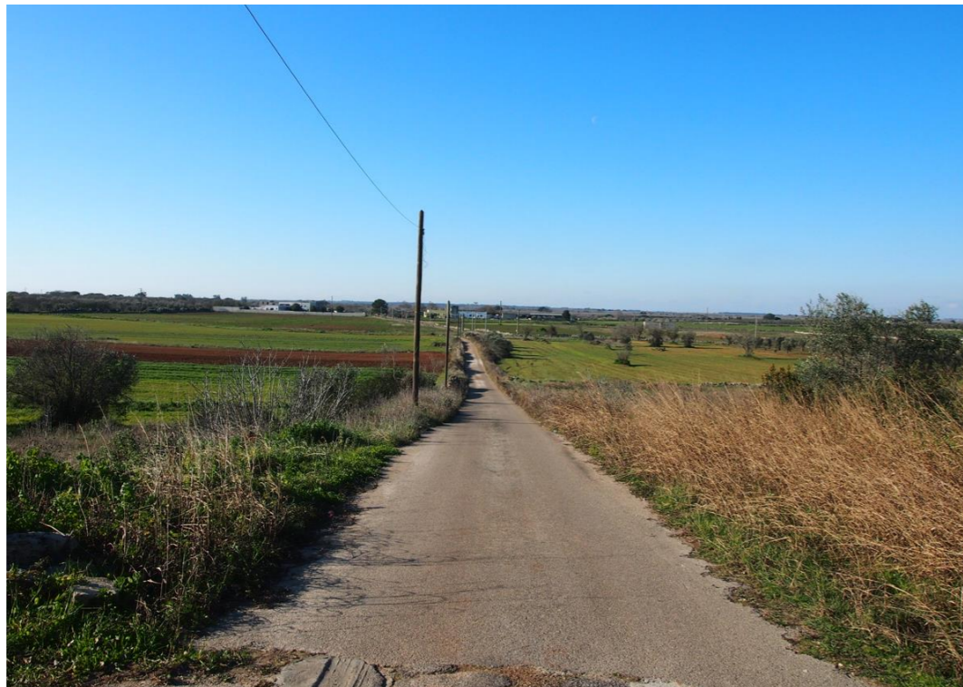
Figura 71. Vista su via Monticelli verso Sud Ovest.
