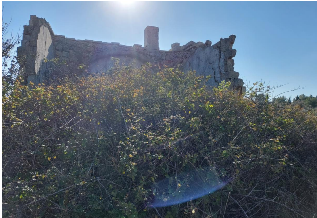
Figura 79. Vista su rudere precedentemente indicato con freccia gialla.
