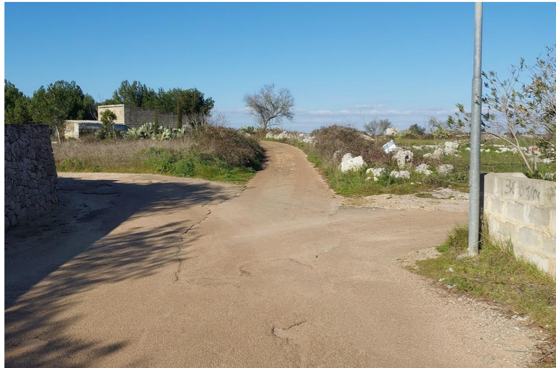
Figura 73. Vista su svincolo in Via dei Serrani.
