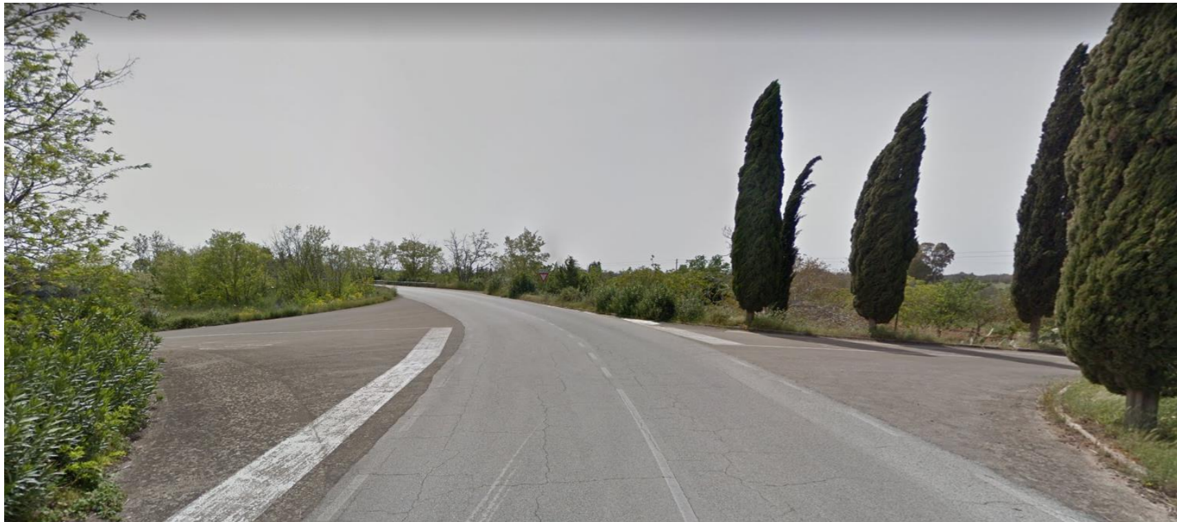
Figura 51. Area in cui sarà realizzata la rotatoria non oggetto di variante localizzativa.
