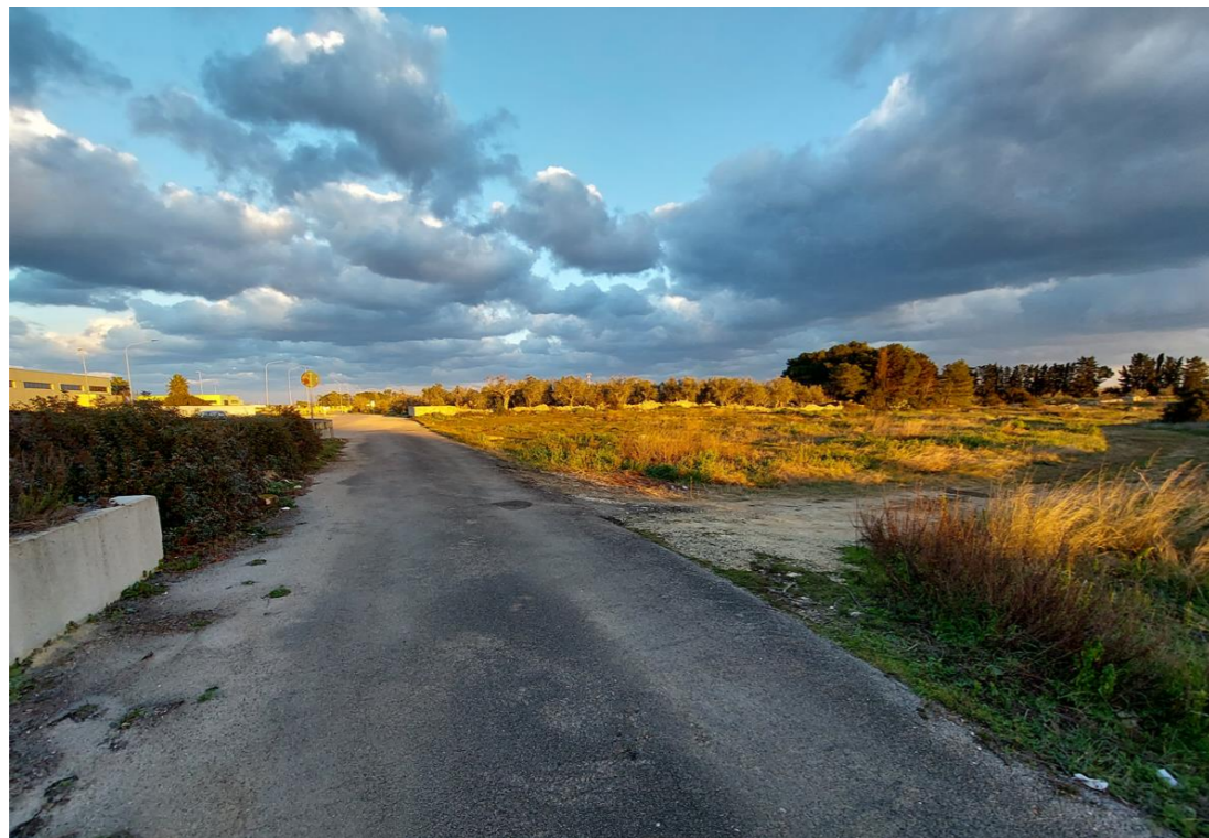
Figura 59. Vista sulla strada esistente in cui si innesterà la strada secondaria precedentemente citata.
