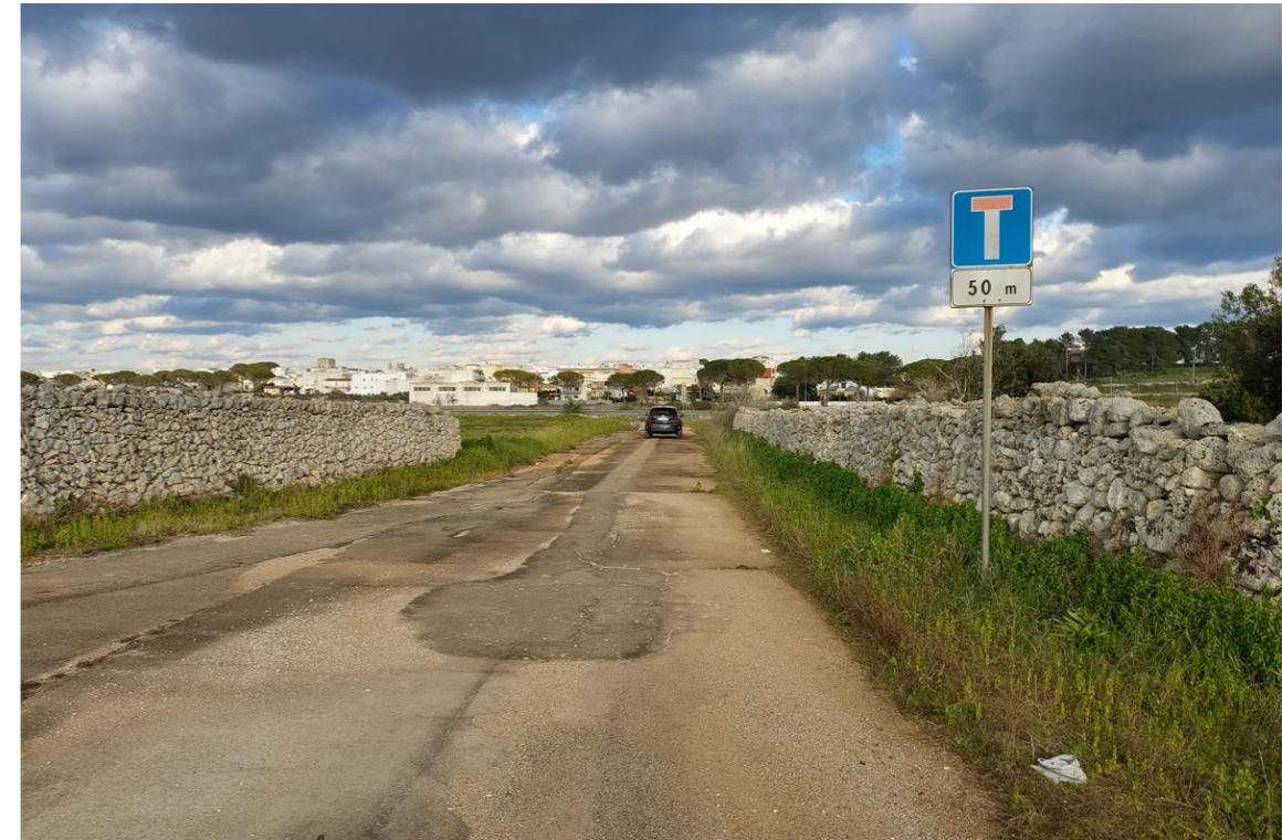
Figura 46. Attuale strada senza uscita che affaccia sulla SS 275 dove sarà realizzata la rampa per il sovrappasso stradale – lato Ovest dell'asse principale.
