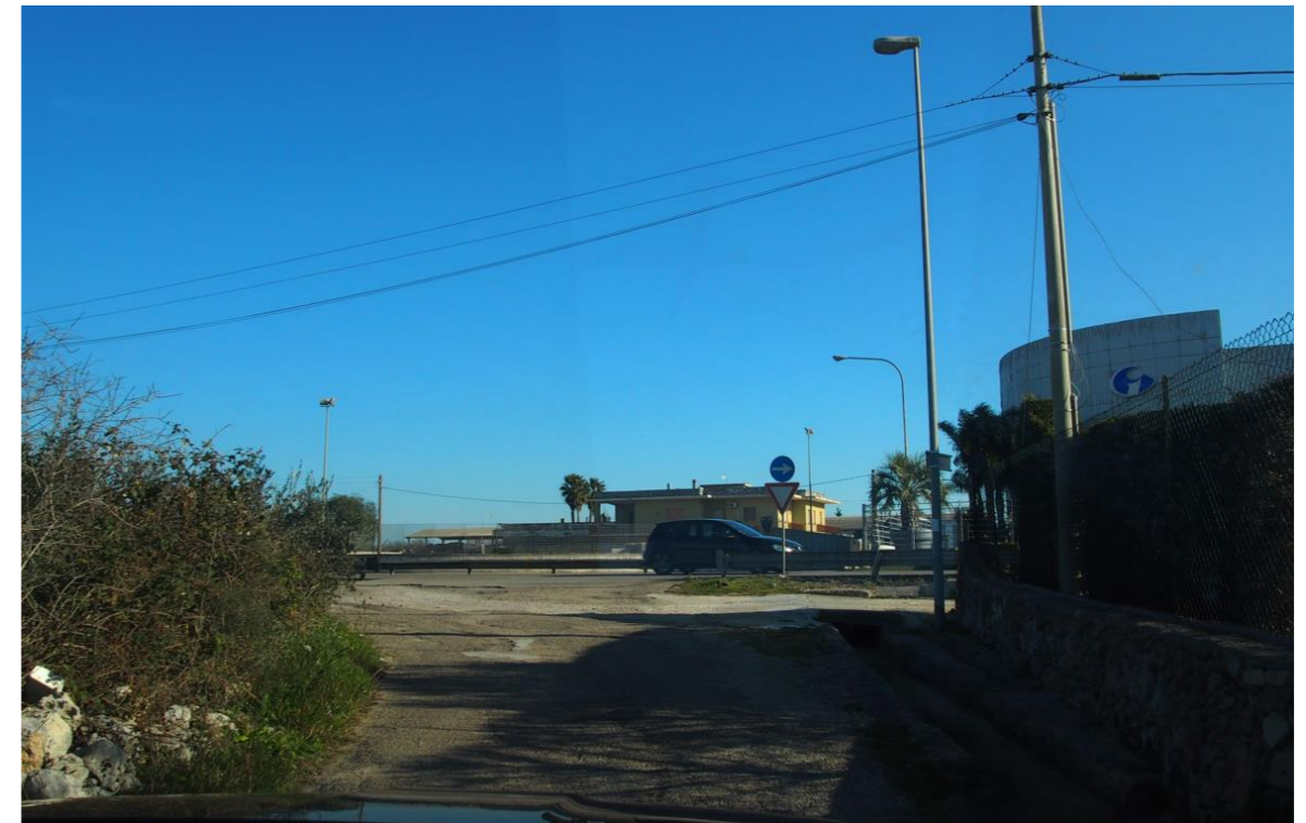
Figura 72. Vista su via Monticelli verso Nord Est in prossimità dello svincolo esistente che verrà sostituito dall'allargamento dell'asse stradale SS 275.
