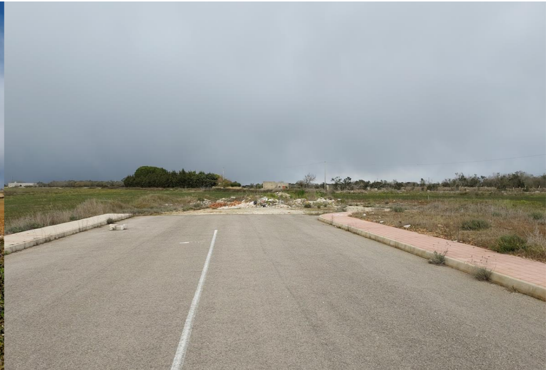
Figura 17. Vista dall'area in cui sarà realizzata la strada complanare e rotonda, strada in parte già realizzata.
