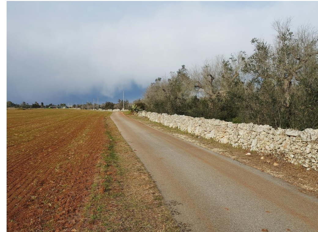
Figura 32. Vista della strada secondaria non oggetto di intervento di adeguamento.
