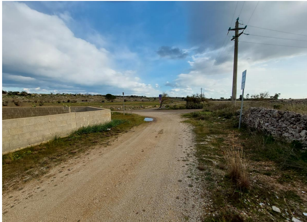
Figura 35. Vista dell'area in cui sarà realizzata la rotonda precedentemente citata.
