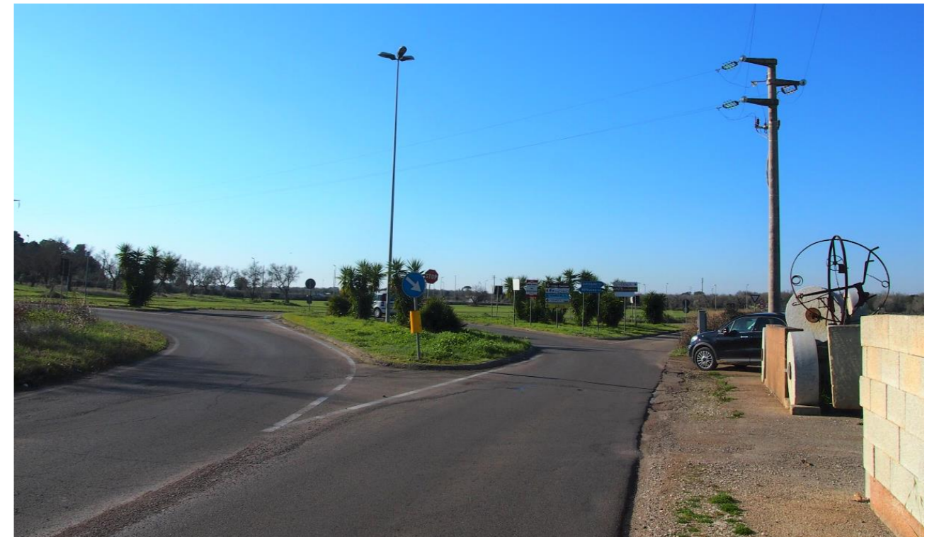
Figura 64. Vista sullo stato di fatto dello svincolo stradale che sarà sostituito dalla rotonda in progetto.
