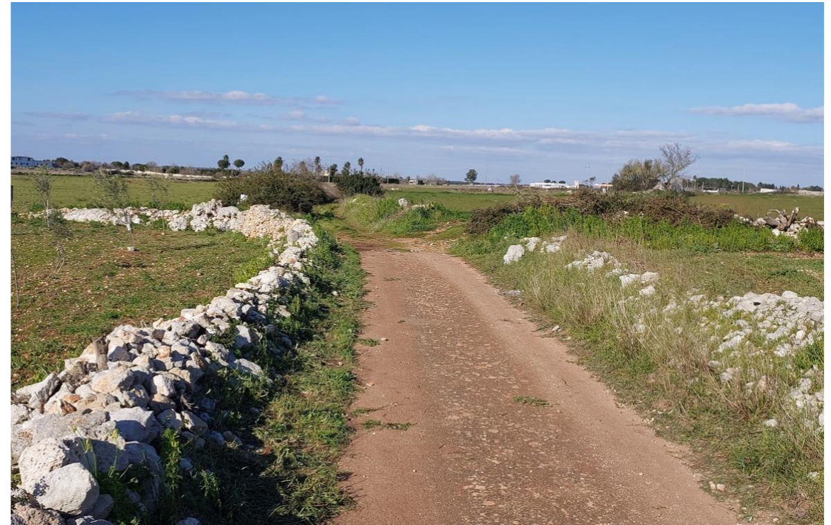
Figura 74. Vista su Via dei Serrani dove la strada non risulta più carreggiabile.
