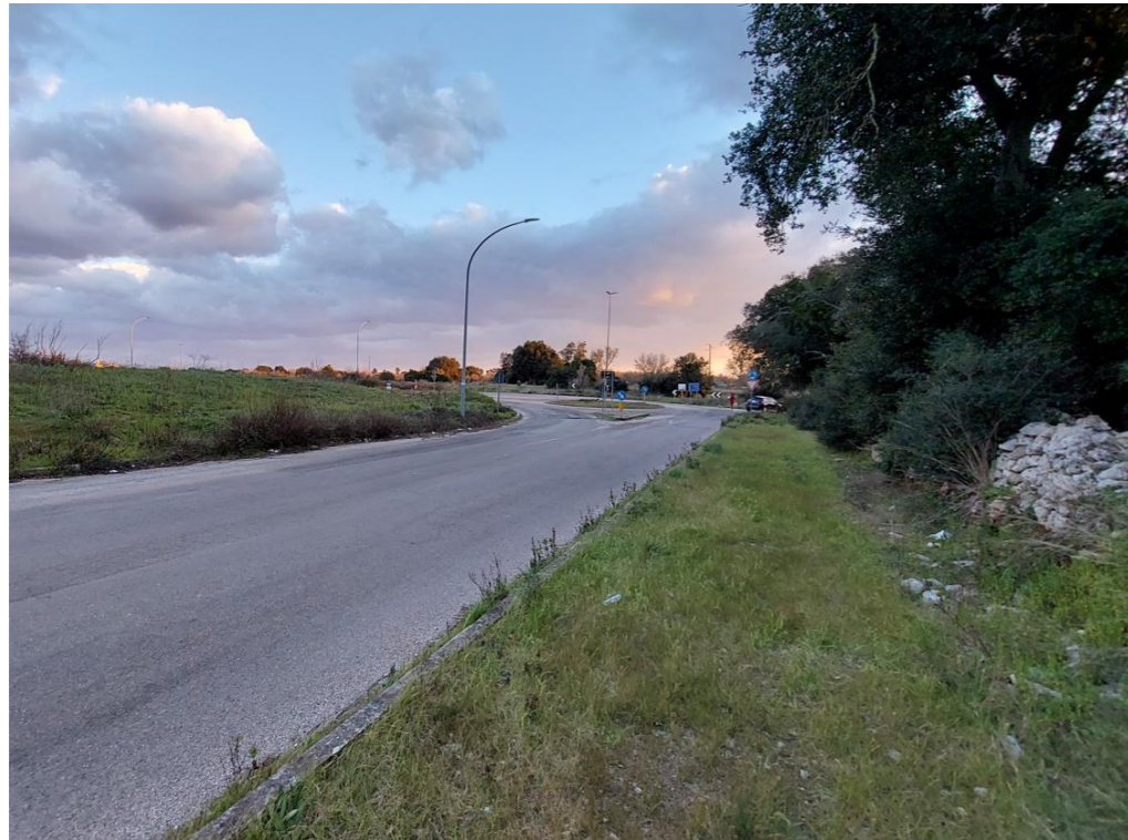
Figura 61. Vista in direzione della rotatoria esistente da braccio Nord esistente.
