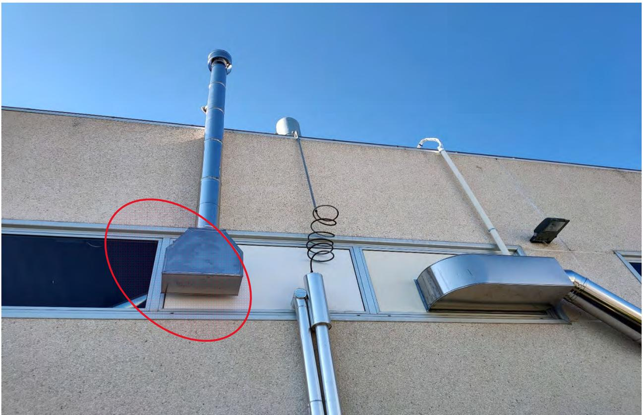
Figura 6 - Foto degli esterni dalla quale si vede il plenum di raccordo delle tubazioni collettate verso il camino
