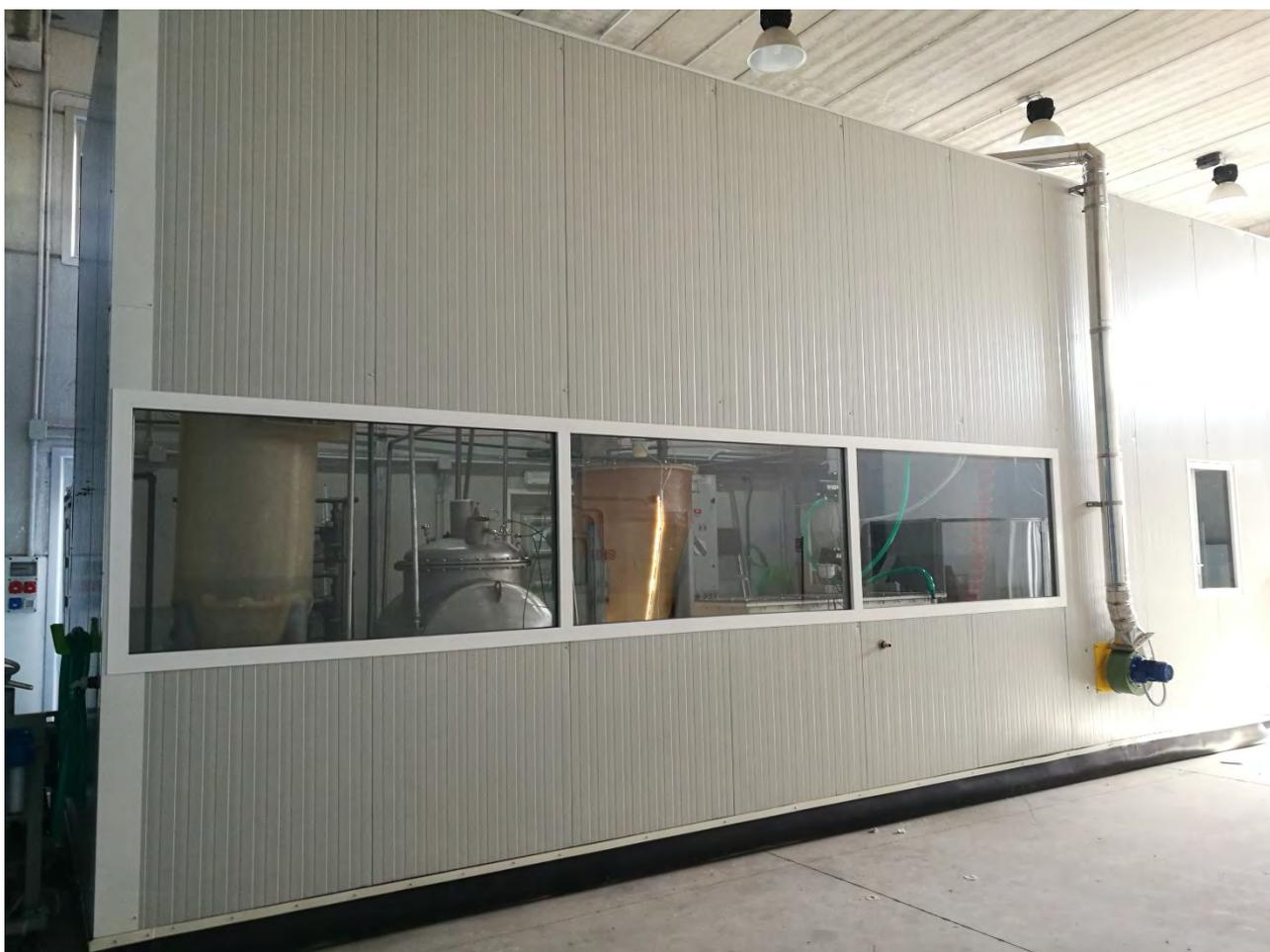
*Figura 2 - Scocca a tenuta nella quale sono ubicati i macchinari che formano l'impianto - foto prese dalle relazioni di progetto*
