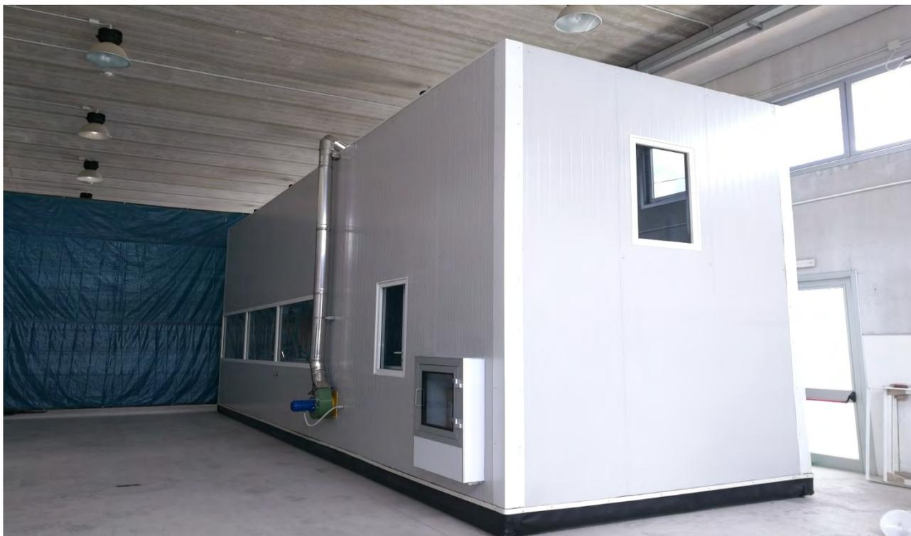
Figura 3 - Container a tenuta nella quale sono ubicati i macchinari che formano l'impianto - foto prese dalle relazioni di progetto
