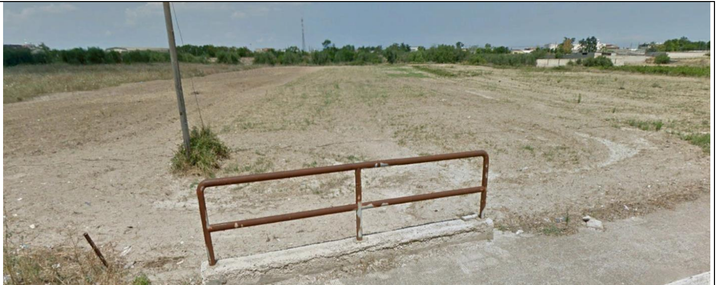
Foto 3 – Vista dell'area di cantiere
