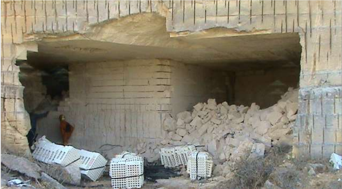
Fig. 6.7 – Ingresso della galleria ANAS013 in cui sono stati riconosciute due direzioni preferenziali di scavo: N54E e N114E. Si evidenzia l'occlusione della galleria in direzione dell'asse stradale in progetto. Archivio 2012
