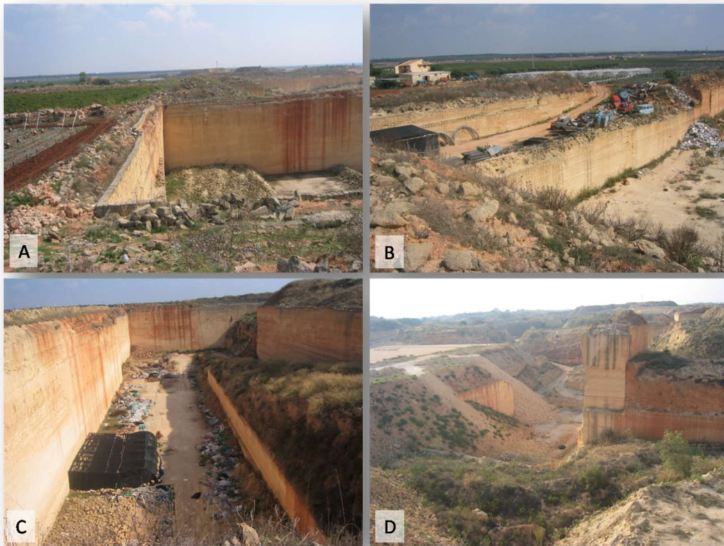
Fig. 5.11 – Cave di calcarenite abbandonate e spesso adibite a discariche abusive. Il tracciato ne sfiora una, che dovrà essere ritombata.
