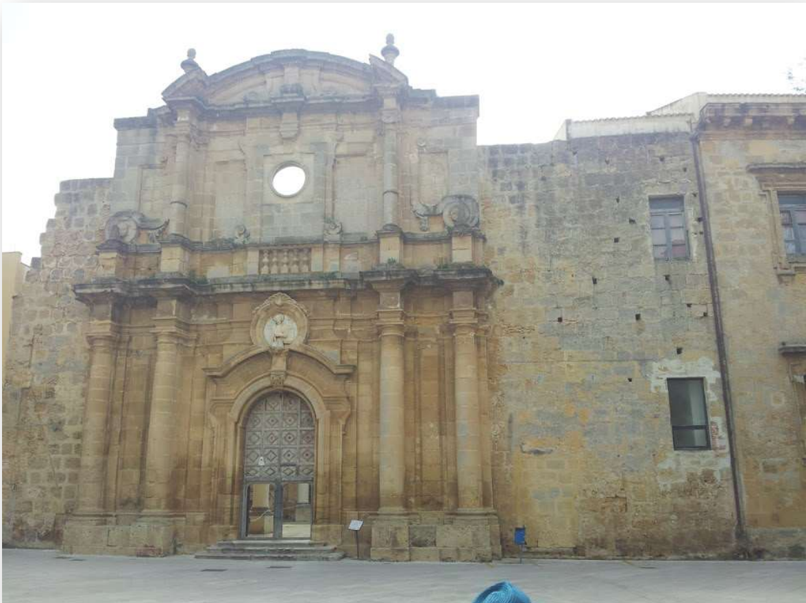
Fig. 2.2 – Esempi di utilizzo della calcarenite nelle costruzioni storiche locali. Resti della facciata della Chiesa di S. Ignazio edificata nel 1701;
