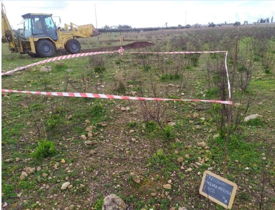
PA02 – Foto 1 – Inizio scavo
