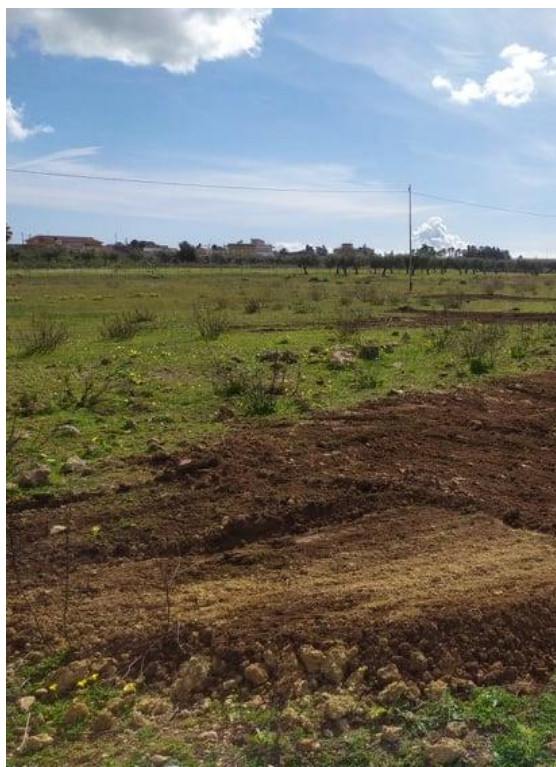
PA4 – Foto 4 – Ripristino area saggio
