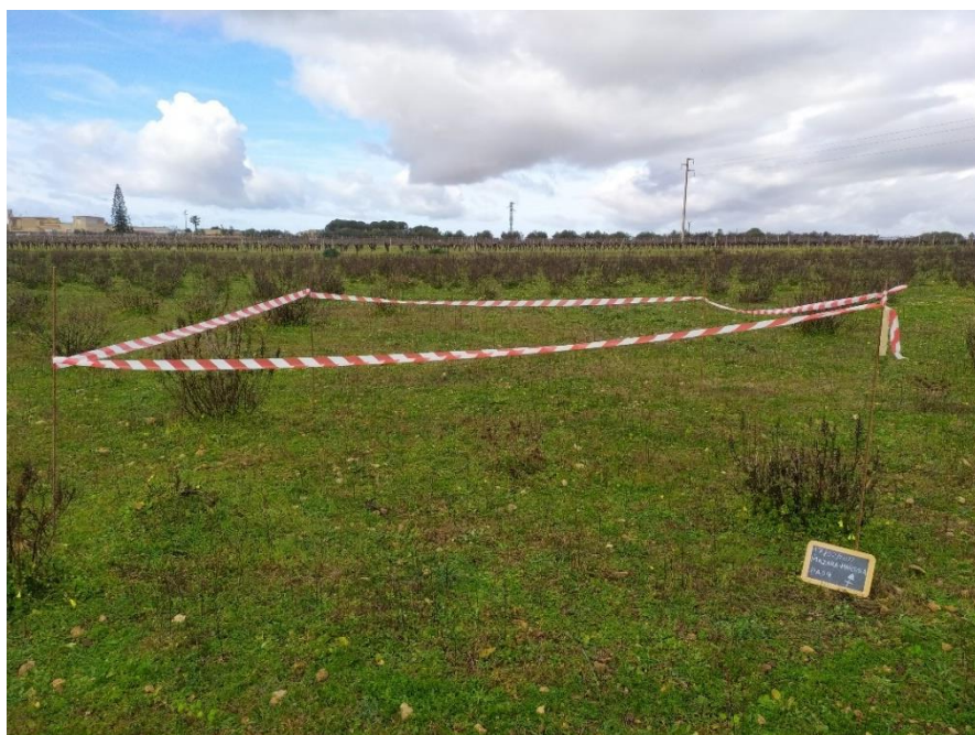
PA04 – Foto 1 – Inizio scavo
