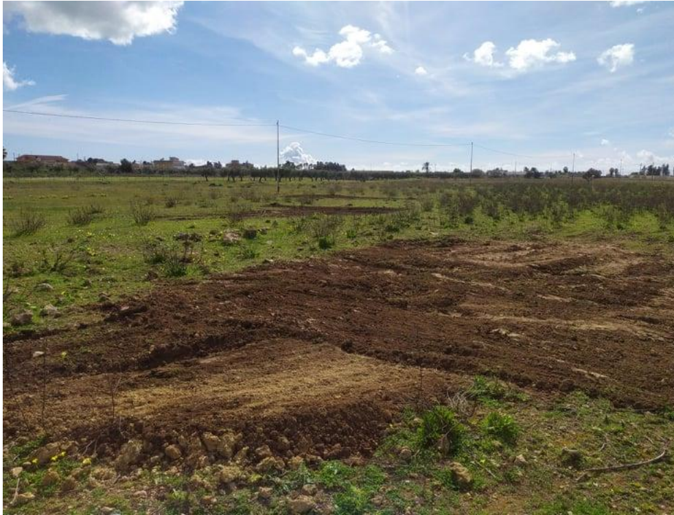
PA02 – Foto 4 – Ripristino area saggio
