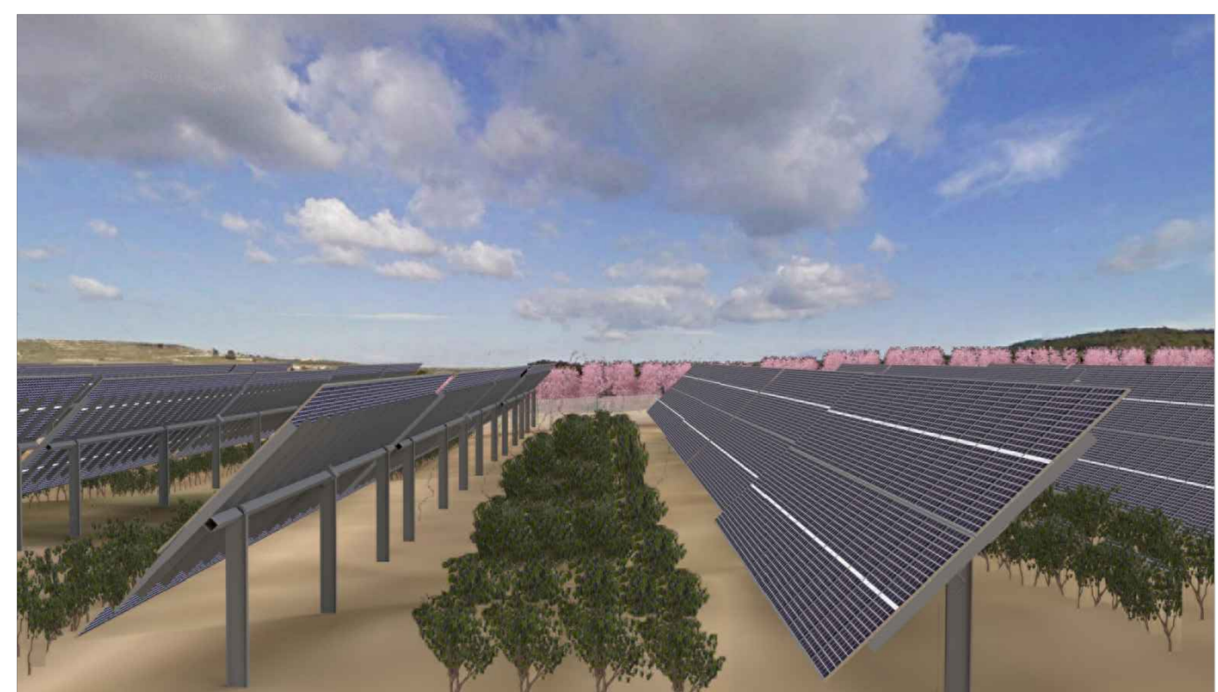
TIPOLOGIA PIANTE DA MITIGAZIONE E DA COLTIVAZIONE: VITE SOTTO I PANNELLI FOTOVOLTAICI E MANDORLO ALL'ESTERNO DELL'IMPIANTO AD USO MITIGATORIO
