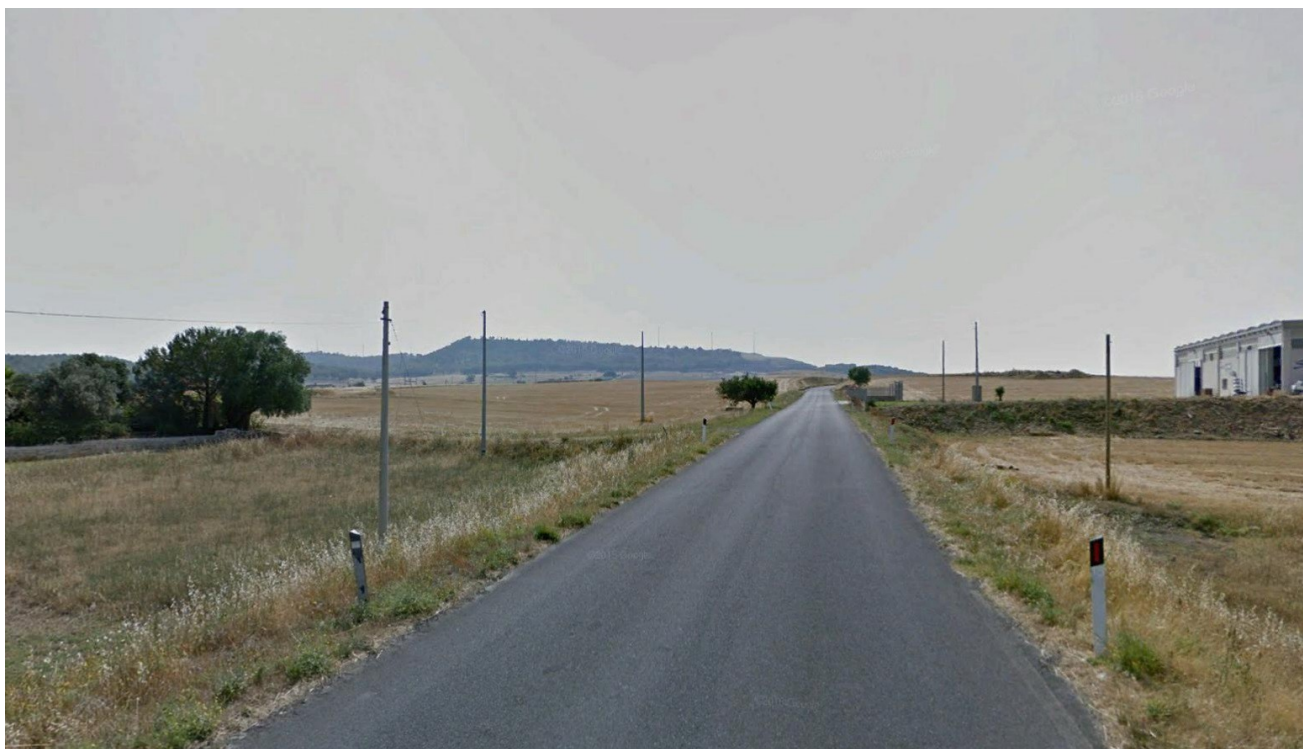
Figura 48 a - Vista 2 - stato ante-operam prossima all'area di impianto FV_MARINEO
