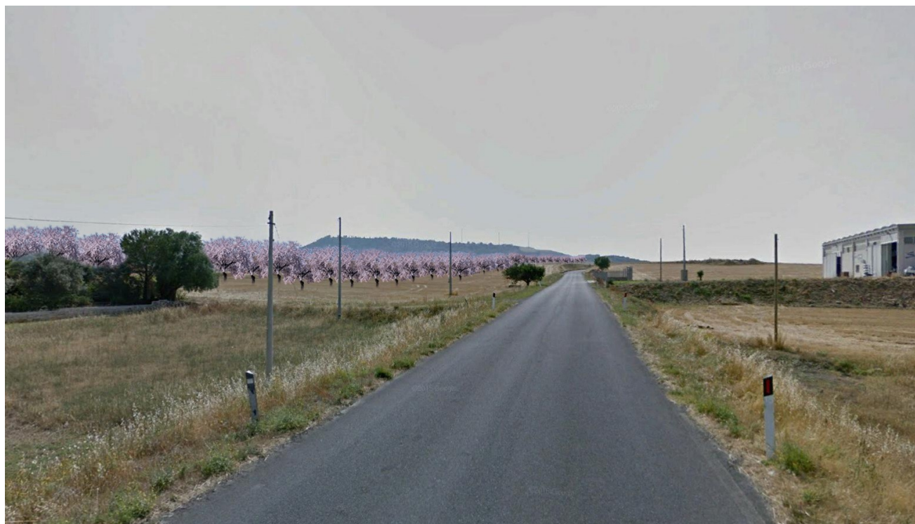
Figura 48 b - Vista 2 - stato post operam prossima all'area di impianto FV_MARINEO
