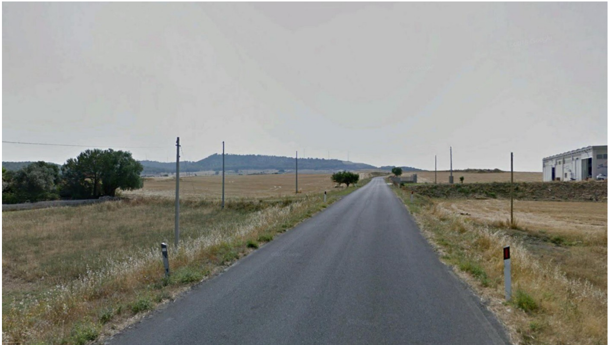
Figura 42 a - Vista 2- stato ante-operam prossima all'area di impianto di Licodia Eubea (CT) - località Marineo
