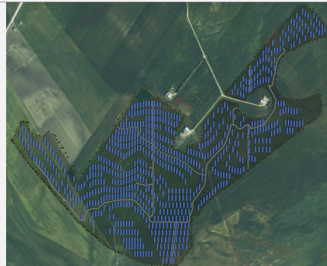
Figura n. 01e: miniatura del fotoinserimento della sola disposizione dei tracker, di gran lunga inferiore rispetto all'occupazione agricola
