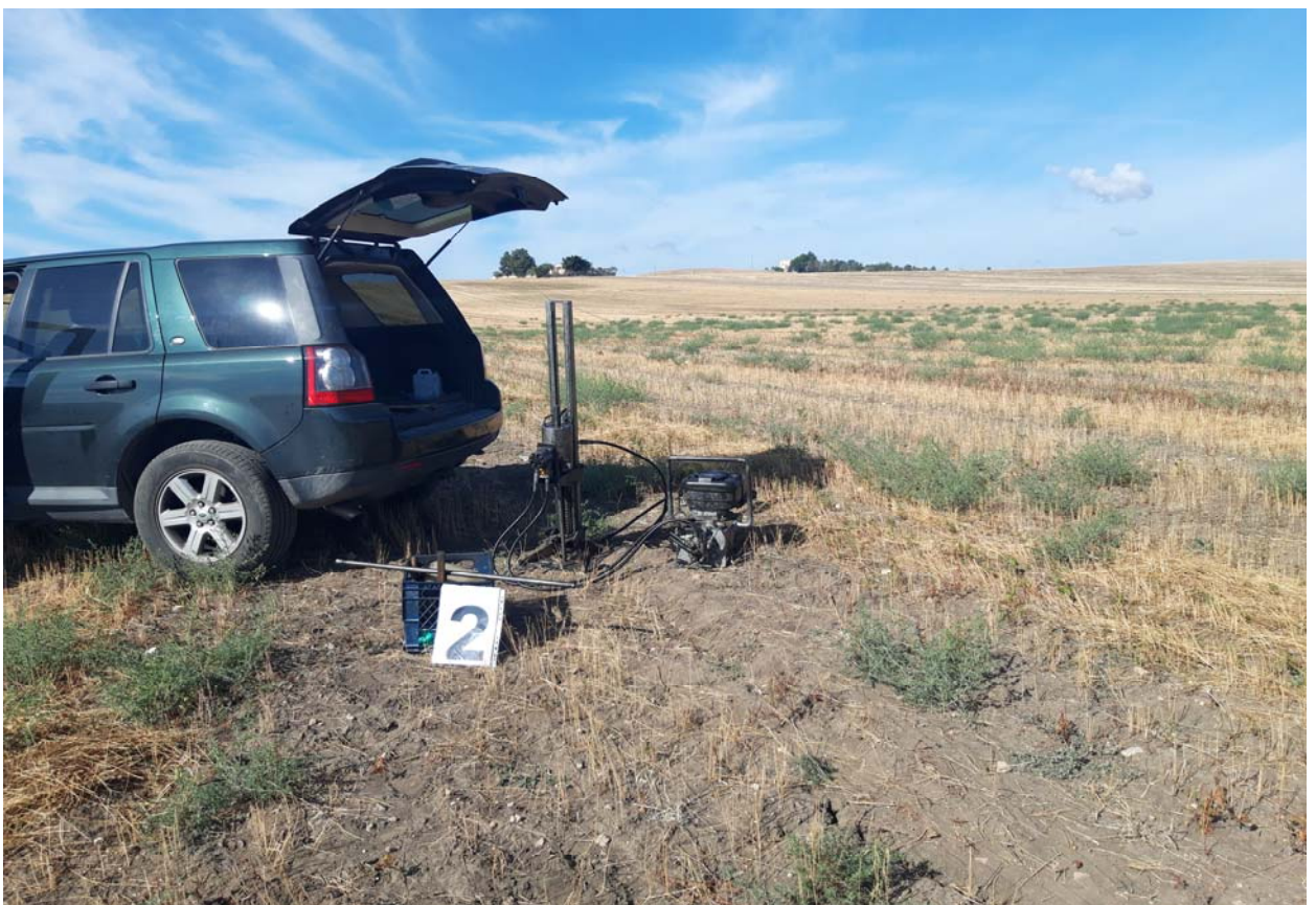
Postazione Prova Penetrometrica Dinamica P2
