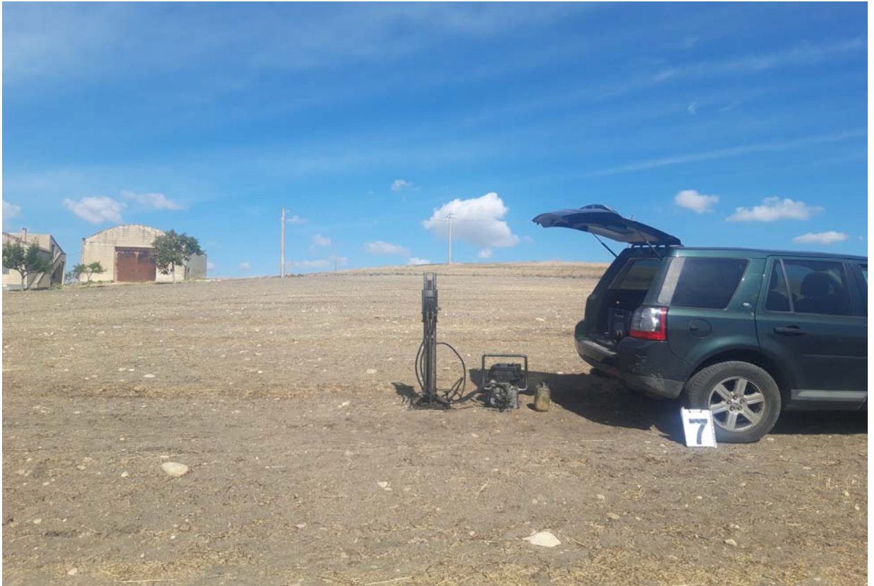
Postazione Prova Penetrometrica Dinamica P7
