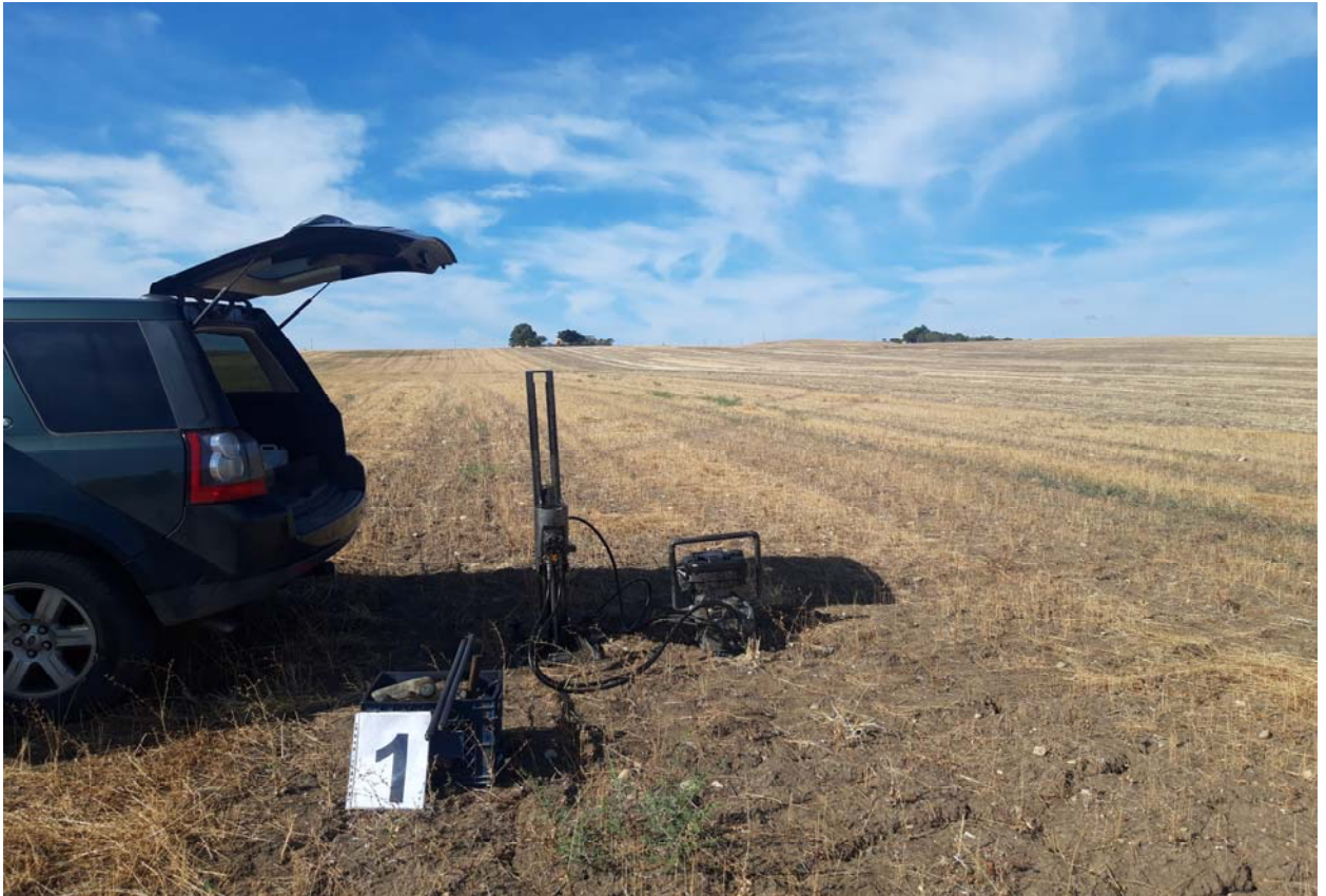
Postazione Prova Penetrometrica Dinamica P1
