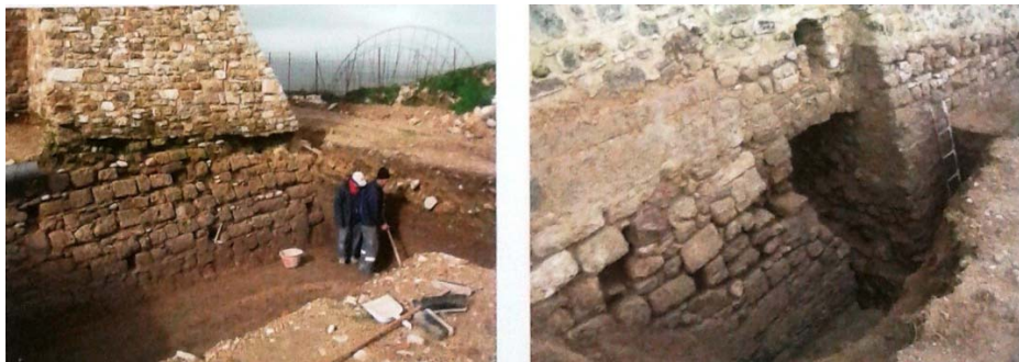
Fig. 10 – Immagini della messa in evidenza delle tecniche costruttive utilizzate per le fondazioni degli elevati.
