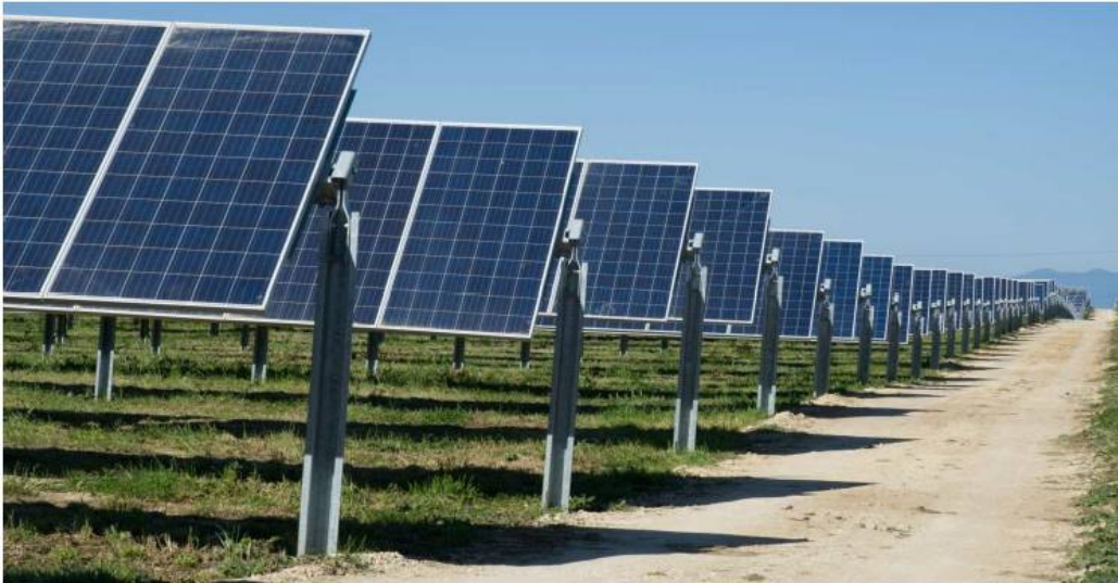
Figura 3: Struttura mobile ad inseguitore solare portamoduli TRACKER
