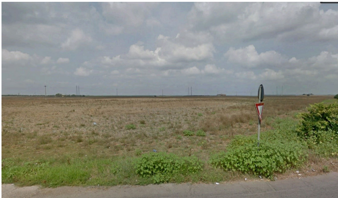
Punto di osservazione 6 – Incrocio della S.P. 109 con la S.P. 107 - si fa rilevare che gli impianti fotovoltaici già esistenti posti prima dell'impianto di progetto non sono visibili.
