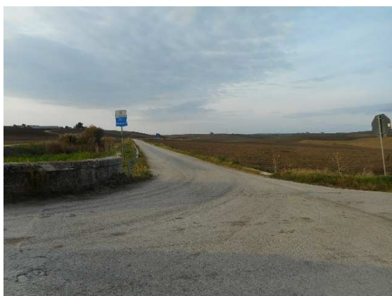
1 - Località Massarnicola, tratto di elettrodotto diretto a NW verso le aree 1 e 2, visto da SE.
