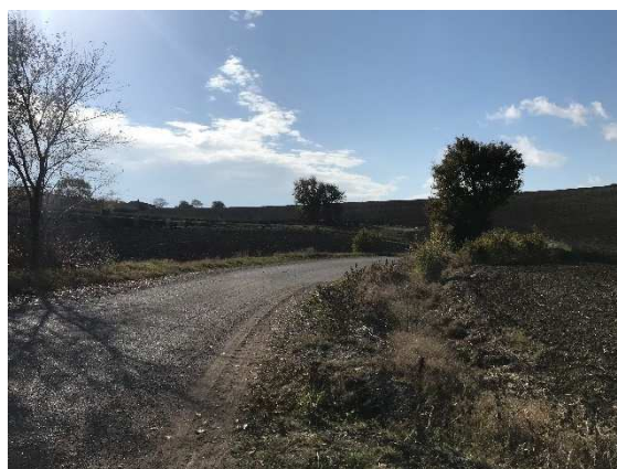
33 - Località Cacciapaglia, tratto di elettrodotto lungo la strada provinciale Pilella-Santo Spirito, diretto a SW, visto da NE.
