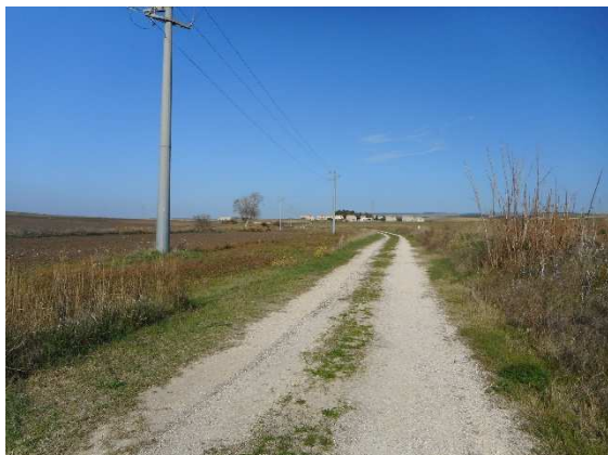
21 - Località Masseria Sorrento, tratto di elettrodotto a N dell'area 1 visto da S.
