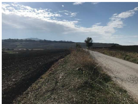
31 - Località Masseria Veltri, tratto di elettrodotto diretto a SW, visto da NE.
