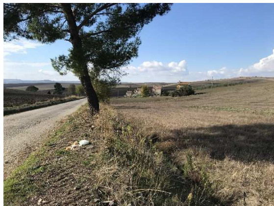
29 - Località Santo Spirito, tratto di elettrodotto diretto a SW, visto da NE.
