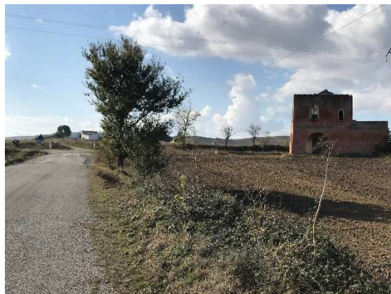
35 - Località Gamarda-Cantoniera, tratto di elettrodotto in prossimità dell'incrocio con la SP 79.
