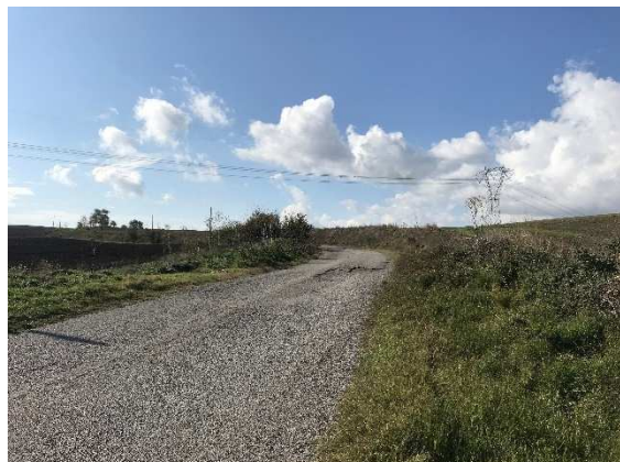
34 - Località Gamarda, tratto di elettrodotto lungo la strada provinciale Pilella-Santo Spirito, diretto a SW, visto da NE.
