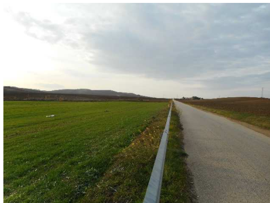
4 - Località Masseria Colangelo, tratto di elettrodotto diretto a NW verso le aree 1 e 2, visto da SE.
