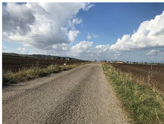
37 - Località Gamarda-Masseria De Marinis, tratto di elettrodotto in prossimità della sottostazione elettrica visto da SE.
