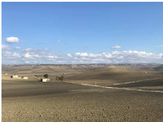
28 - Località Monte della Croce, tratto di elettrodotto proveniente da NE visto da SW.
