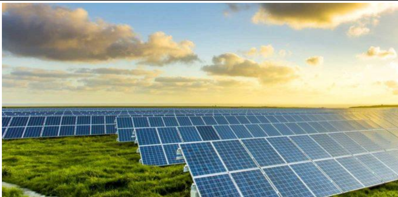
Esempio di impianto FV, fase di esercizio dei moduli FV.
