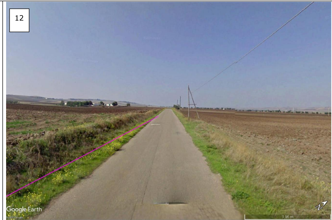
Punto di presa "12" : Vista del tracciato del cavidotto MT : SP79 nei pressi dell'ampliamento della S.E. Terna
