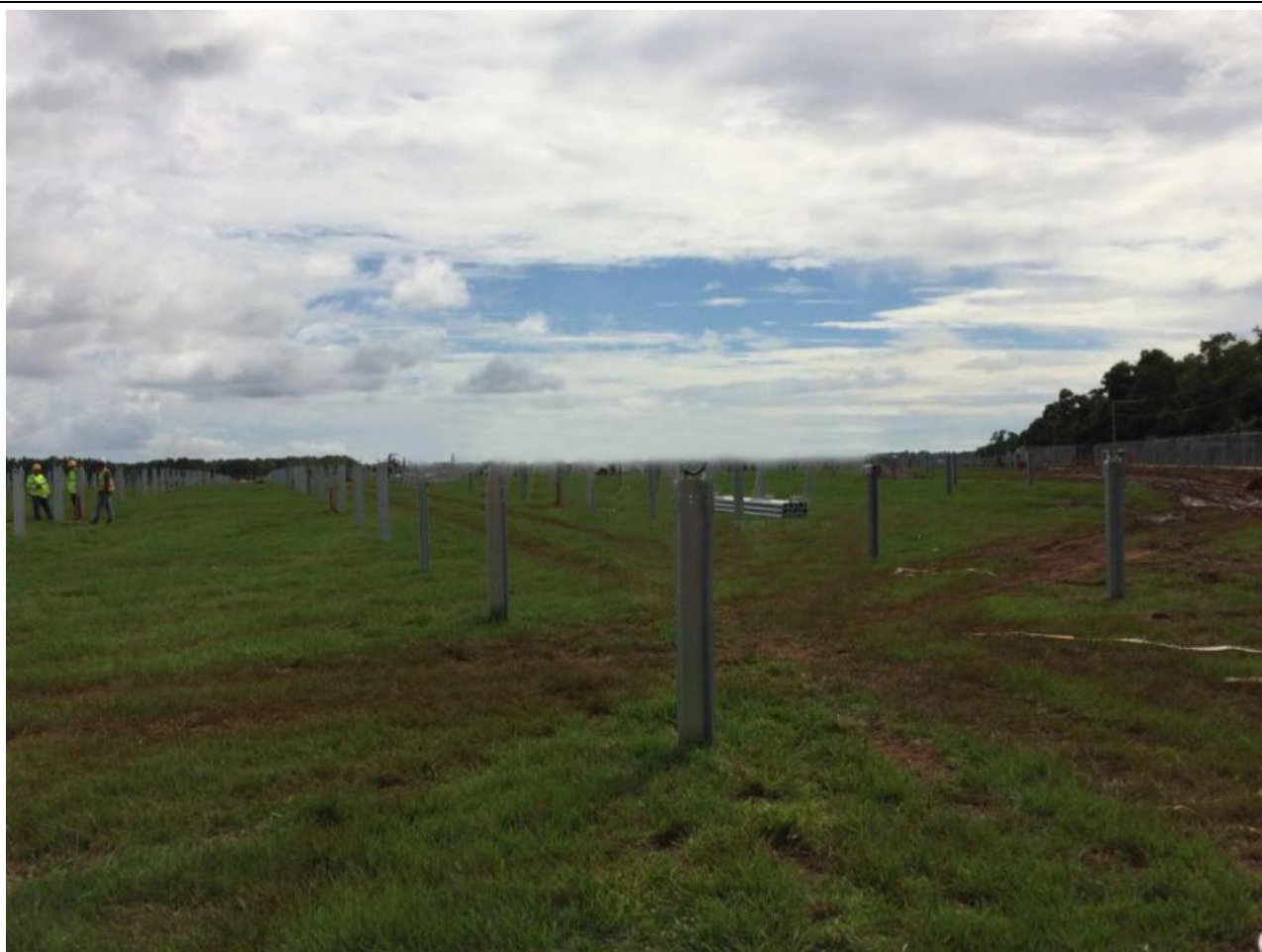
Esempio di impianto FV - .Fase di cantiere installazione pali di sostegno.
