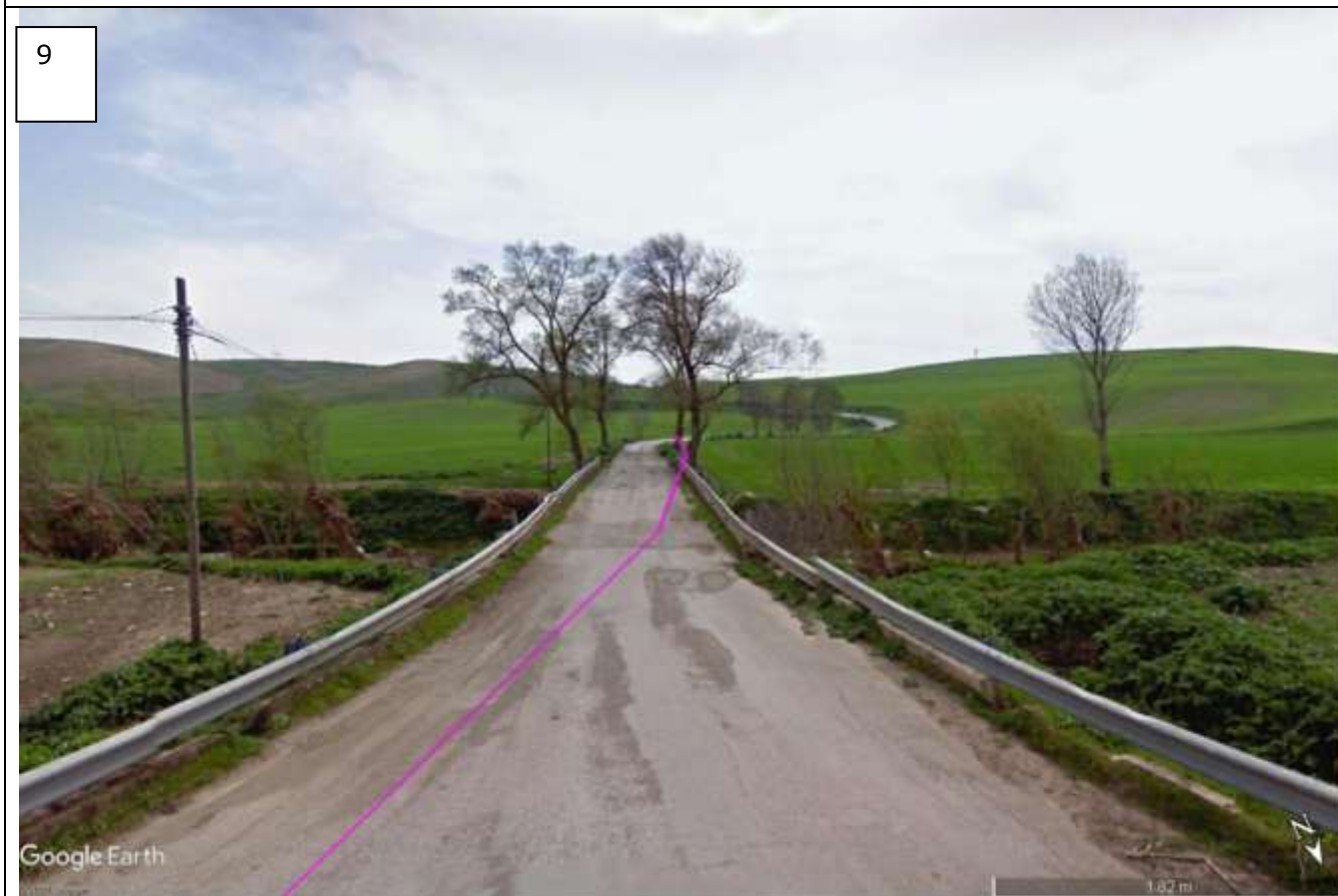
Punto di presa "9" : Vista del tracciato del cavidotto MT : incrocio della SP 129 con la Strada Provinciale Pilella Santo Spirito, con attraversamento su canale
