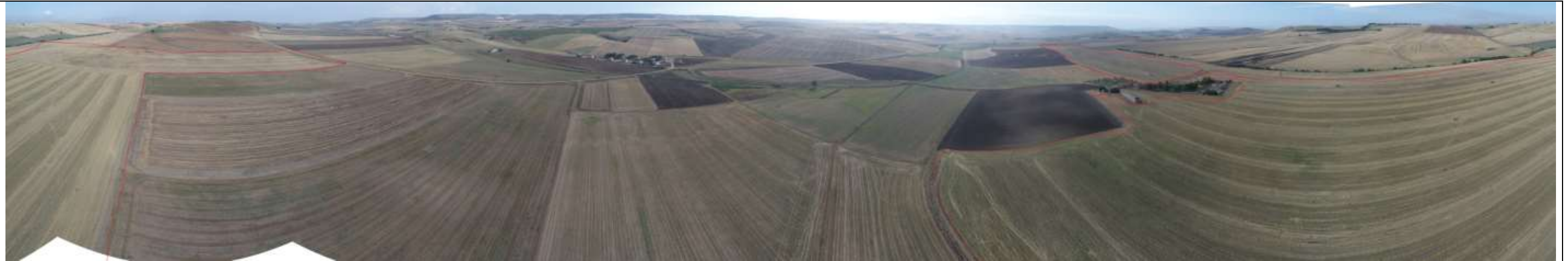
Panoramica delle aree di intervento eseguita dal DRONE in prossimità della Mass. Sorrento - CAMPO FV
