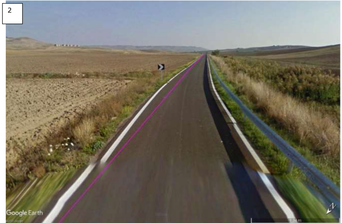
Punto di presa "2" - SP7 - incontro di un tombino: Vista del tracciato del cavidotto esterno MT
