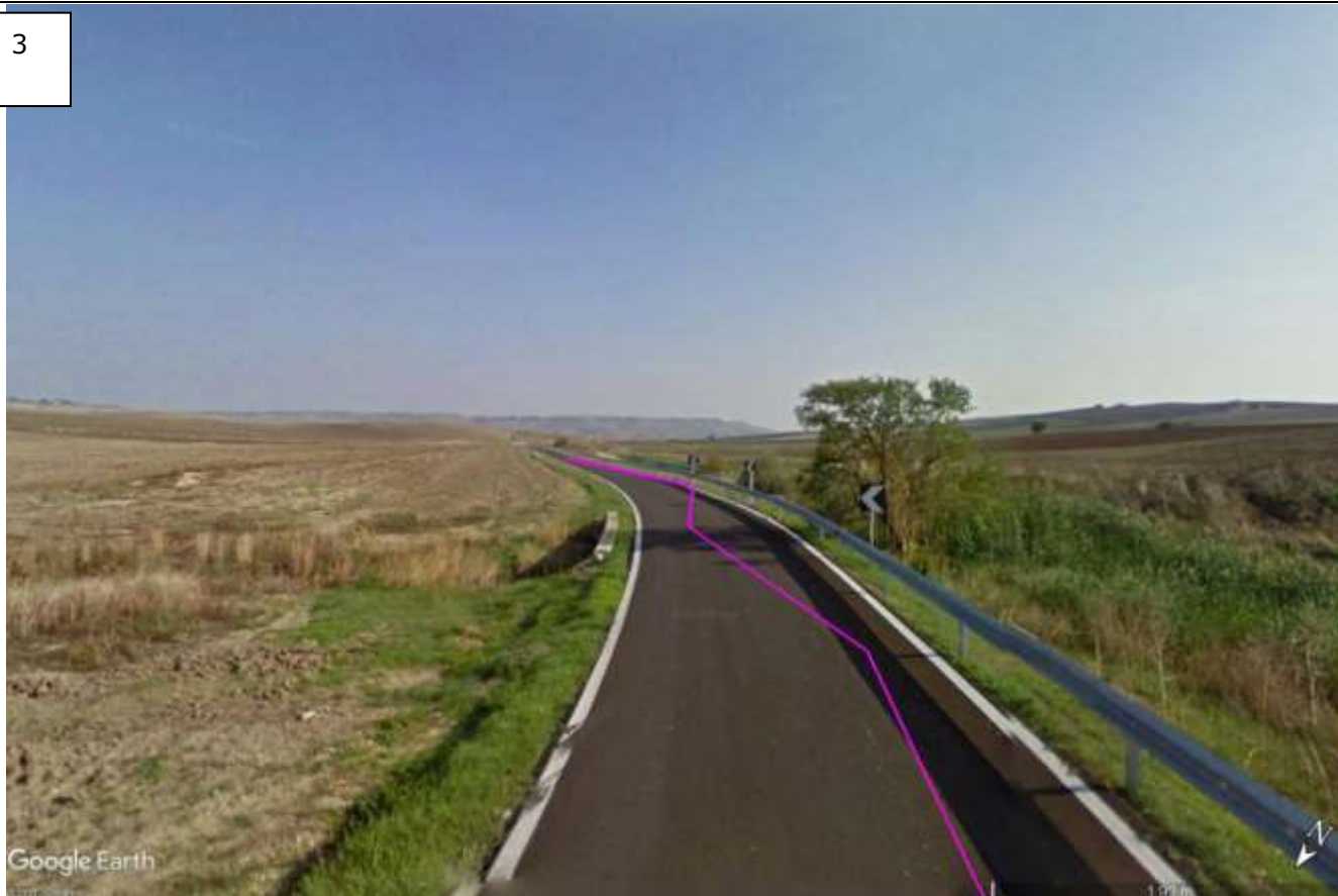
Punto di presa "3" - SP7 - incontro di un tombino: Vista del tracciato del cavidotto esterno MT
