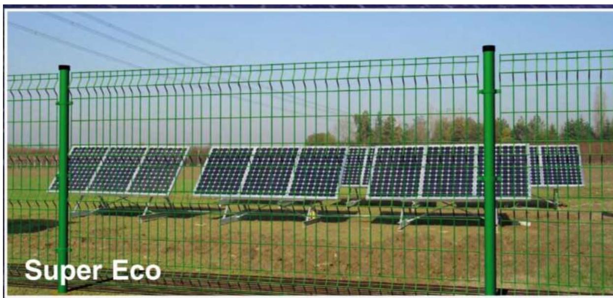
Fig: Tipico della recinzione perimetrale (in quella installata sarà sempre lasciata una luce libera di 10 cm da terra)
