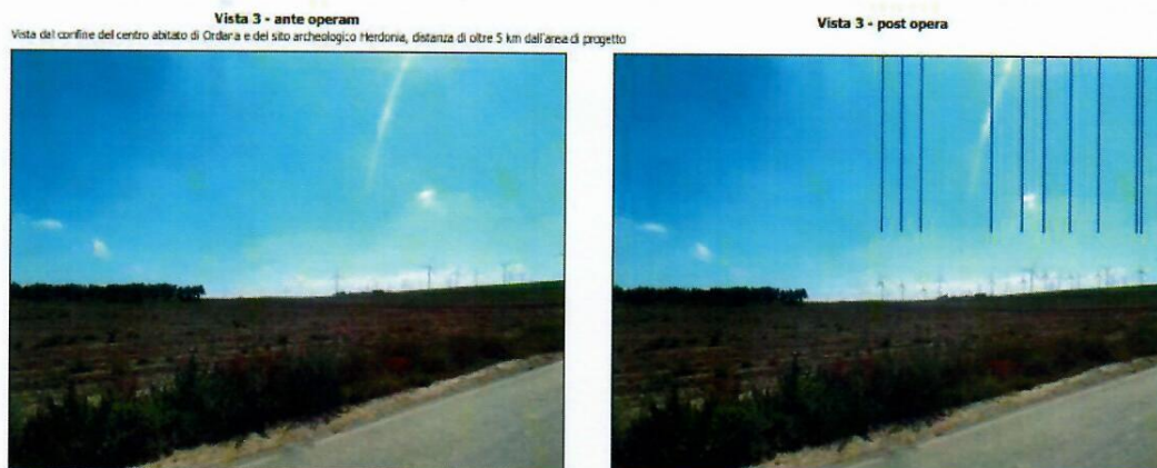
Vista dell'area dell'impianto (ante e post-operam) dal centro abitato di Ortona e dal sito archeologico Herdonia (tratto dall'elaborato Fotoinserimenti ).
