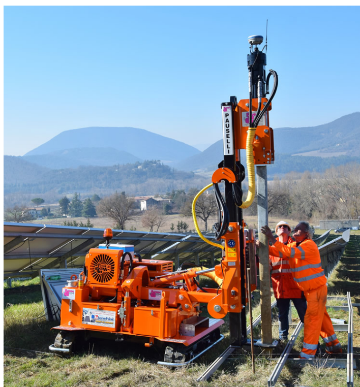
Infissione "a battipalo" dei sostegni dei Tracker
