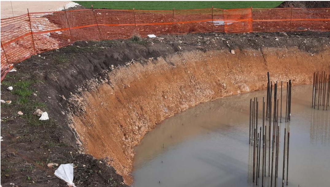
Foto 8 – Scavo in prossimità del profilo sismico SR2-MASW2
