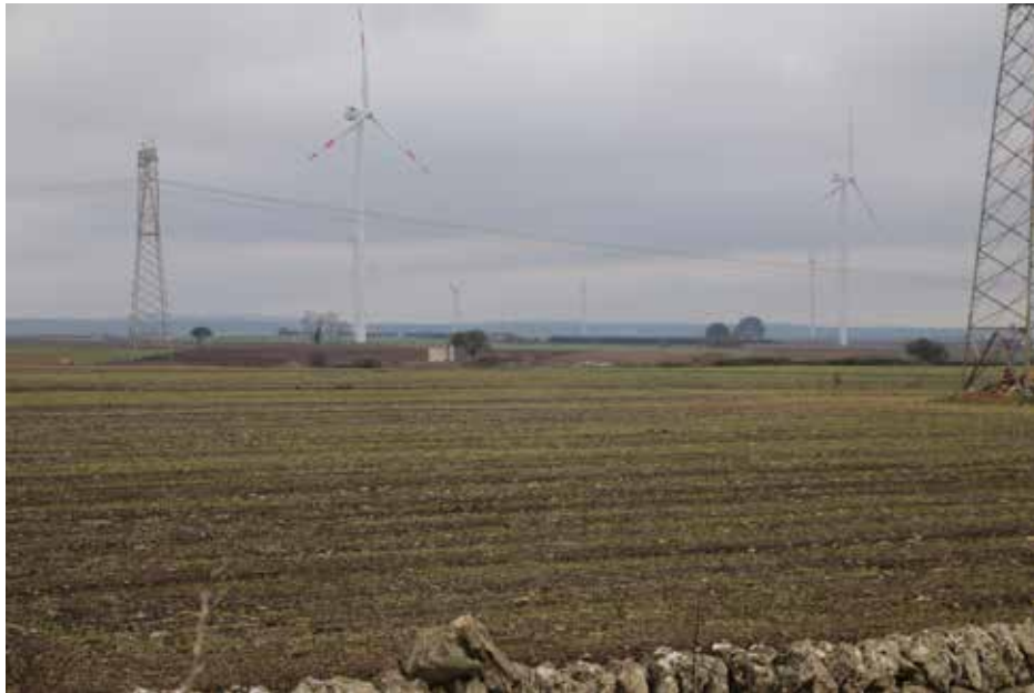
IMG_5517_FV_Terrusi_Campo 4 panoramica da S Stazione Terna.jpg
