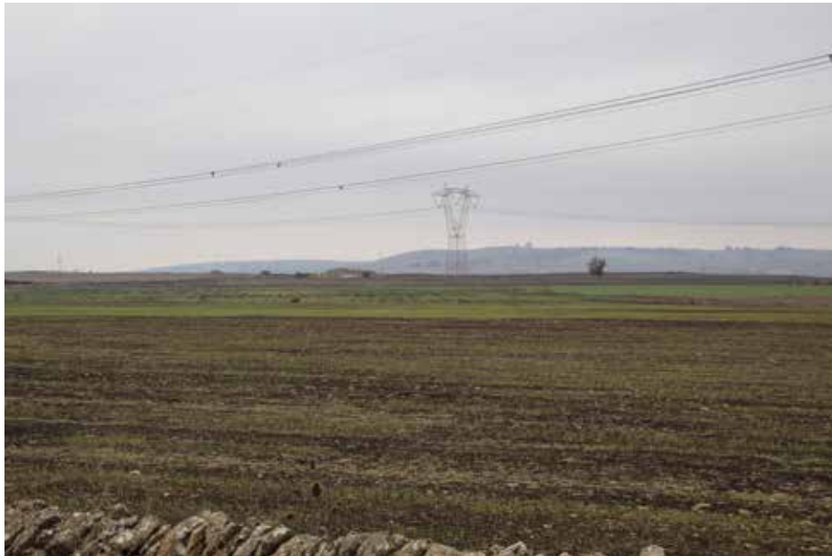
IMG_5514_FV_Terrusi_Campo 4 panoramica da S Stazione Terna.jpg
