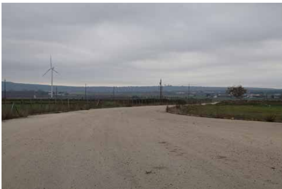
IMG_5499_FV_Terrusi_Stazione Terna S.jpg
