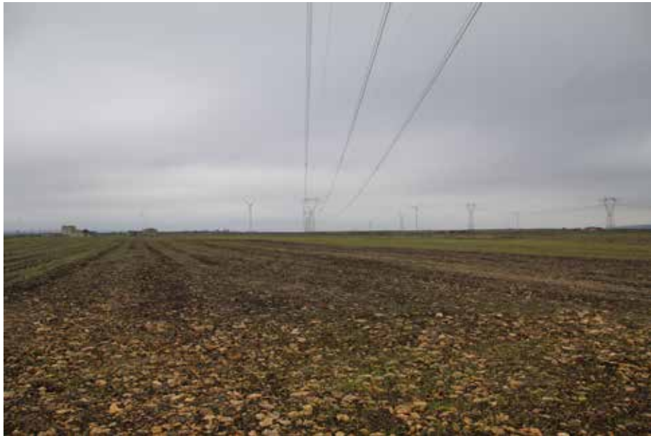
IMG_5526_FV_Terrusi_Campo 4_Tralicci Terna.jpg
