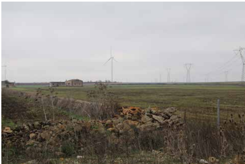
IMG_5512_FV_Terrusi_Campo 4 panoramica da S Stazione Terna.jpg
