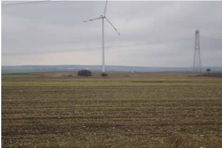
IMG_5516_FV_Terrusi_Campo 4 panoramica da S Stazione Terna.jpg
