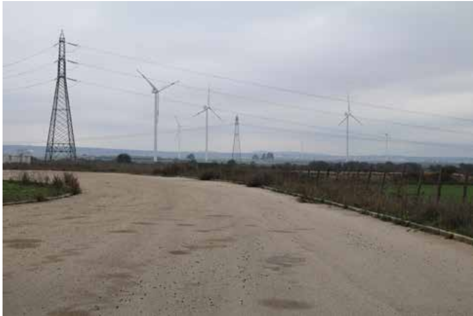
IMG_5497_FV_Terrusi_Stazione Terna N.jpg
