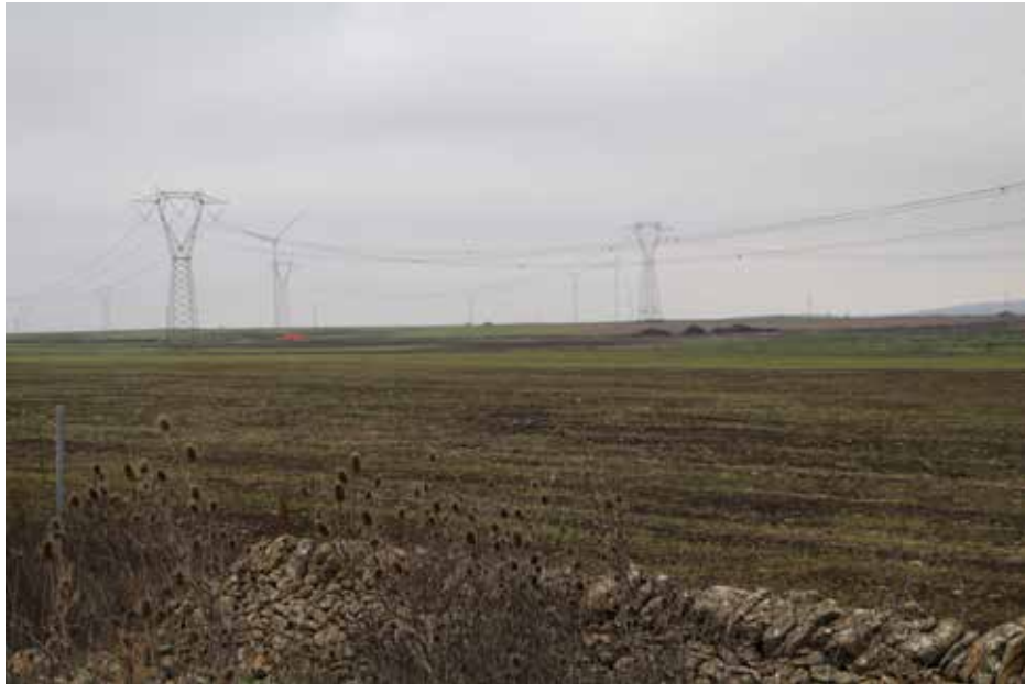
IMG_5513_FV_Terrusi_Campo 4 panoramica da S Stazione Terna.jpg
