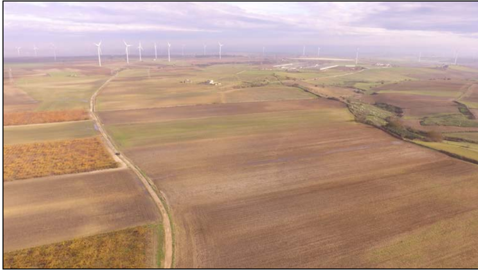
Figura 3. Vista nord dell'area da drone.
