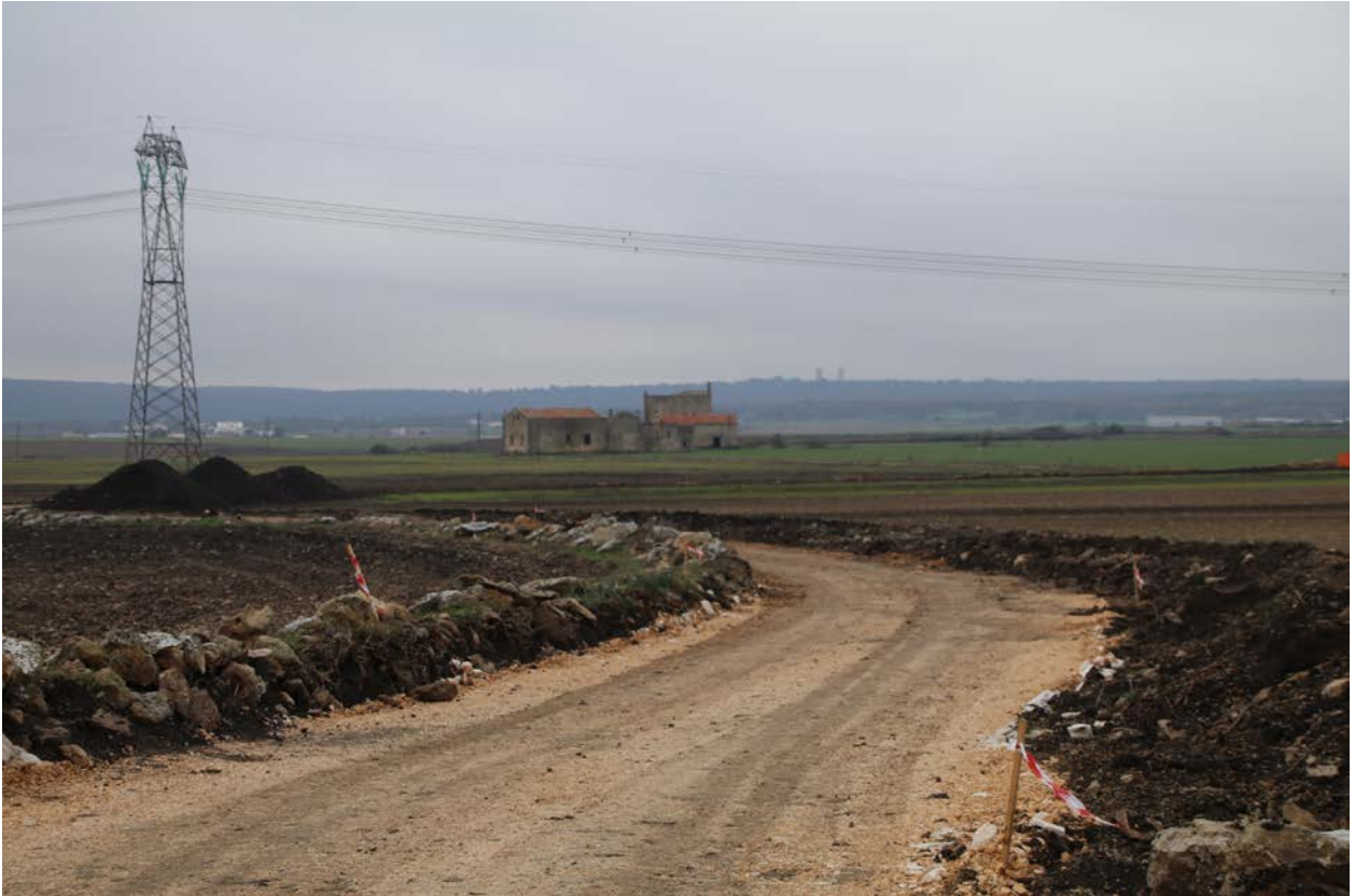
Figura 27. Strada di servizio in costruzione in Terrusi 3.
