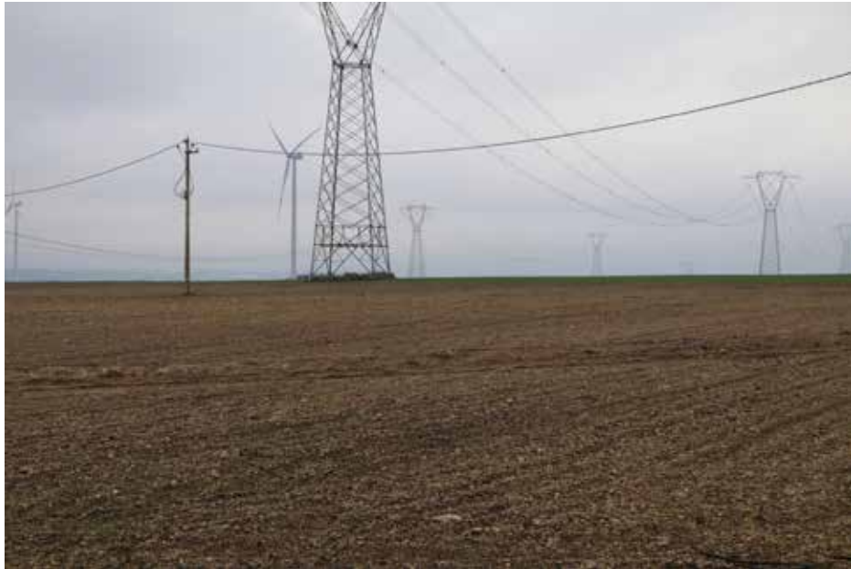
IMG_5554_FV_Terrusi_Campo 3_da S.jpg
