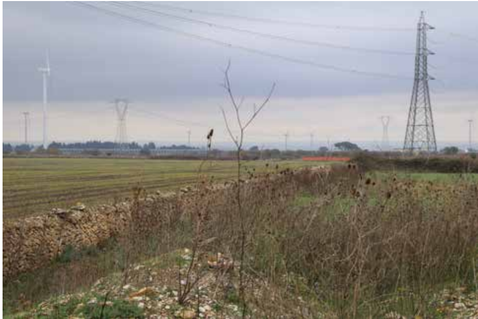
IMG_5519_FV_Terrusi_Campo 4 panoramica da S Stazione Terna.jpg
