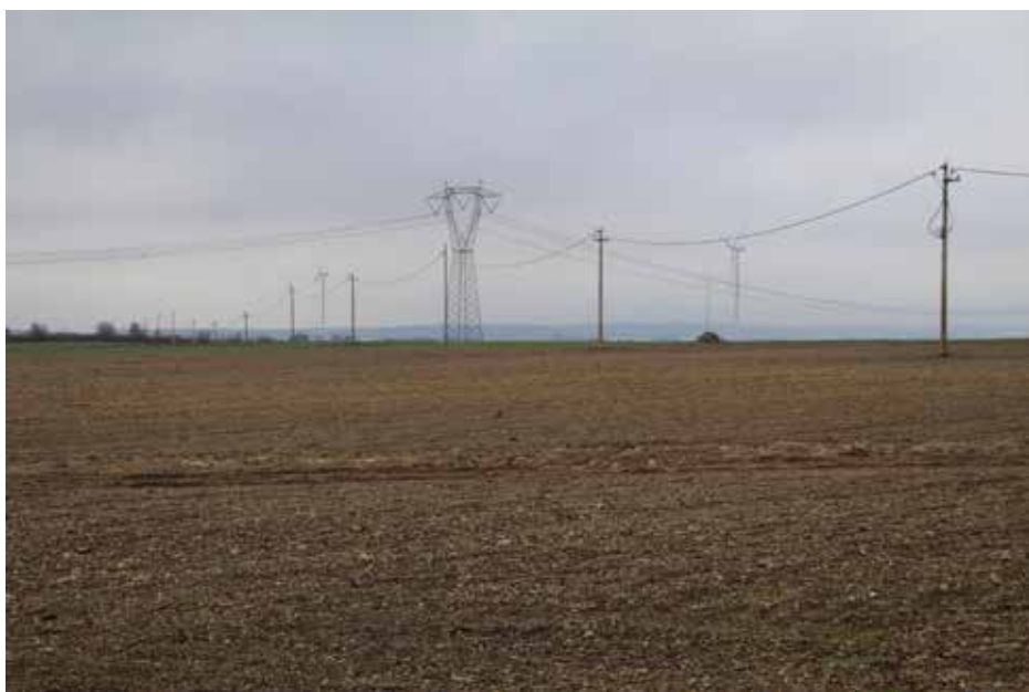
IMG_5553_FV_Terrusi_Campo 3_da SE.jpg
