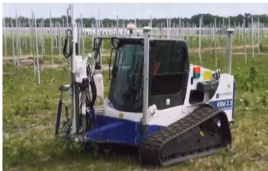
Fig. 48. Esempio di fissaggio delle strutture di supporto
