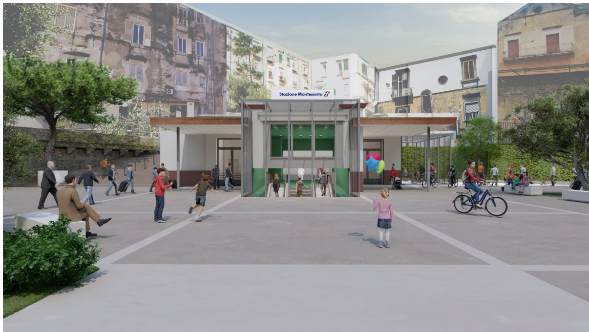
Vista del Fabbricato Viaggiatori
