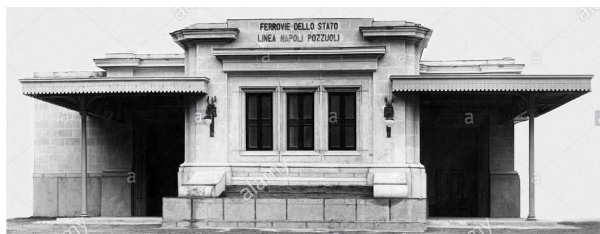
Fabbricato Viaggiatori – Foto storica del prospetto sul piazzale di stazione
