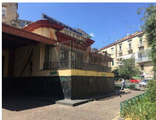
Fabbricato Viaggiatori – Foto del prospetto sul piazzale di stazione
