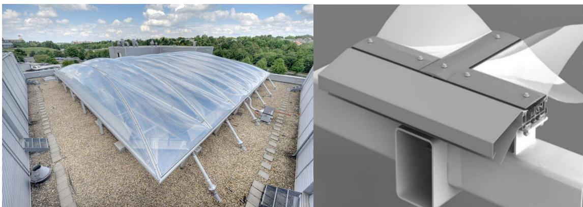
*Immagine esemplificativa della copertura in ETFE e dettaglio costruttivo*
