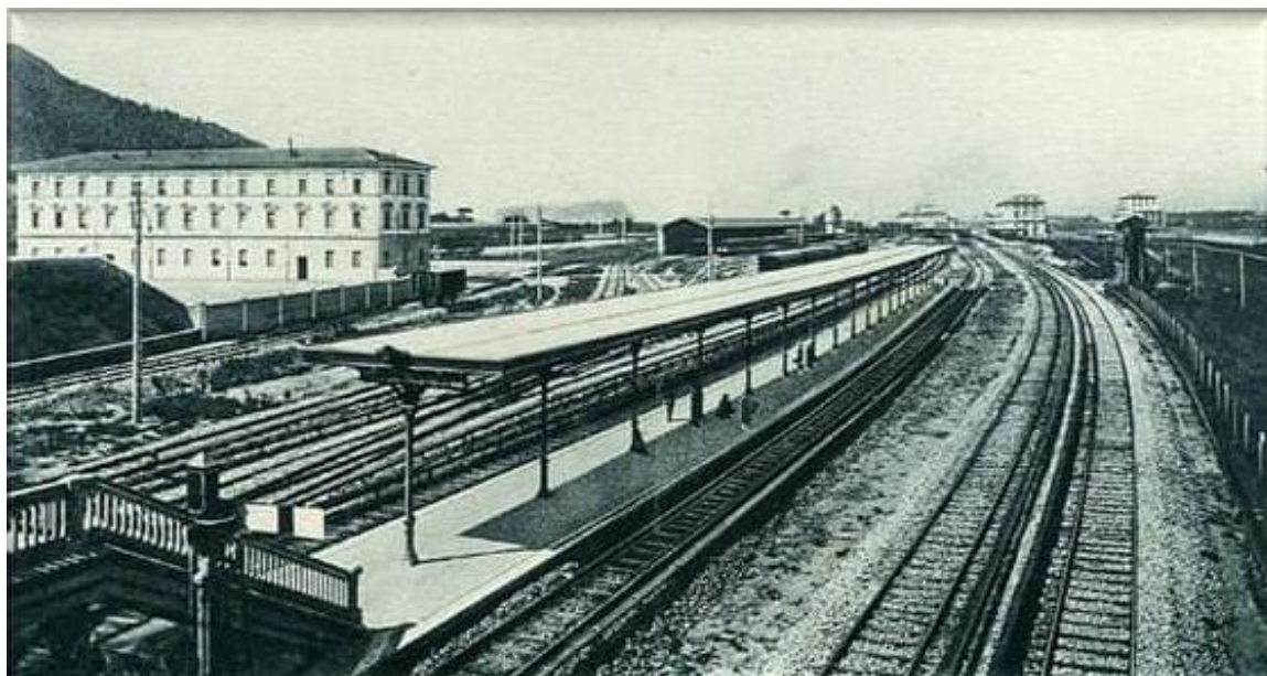
Veduta della banchina di stazione
