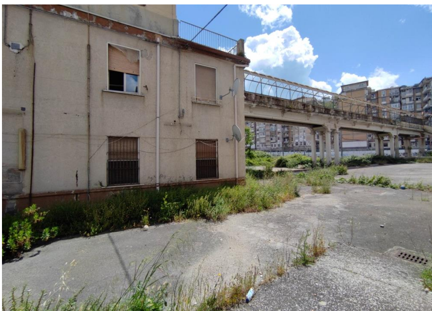
Foto dell'area esterna del Fabbricato Viaggiatori - quota banchina
