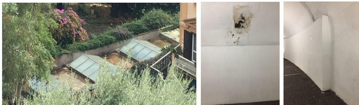
Foto della copertura e delle superfici verticali della galleria
