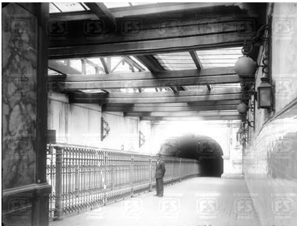
Foto storica - Atrio di stazione
