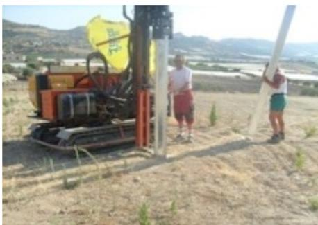
la struttura porta moduli sarà ancorata al suolo tramite pali in acciaio zincati a caldo (per resistere alla corrosione per tutta la durata del progetto) a sezione omega; i pali saranno direttamente battuti nel terreno ad una profondità massima di 2,00 mt con apposita macchina battipalo senza uso di materiale di ancoraggio, mentre l'altezza del palo fuori terra è massima di 1,3 mt (altezza asse di rotazione) quindi lunghezza totale del palo mt 3,30 per un peso di circa 40 kg/cad.
