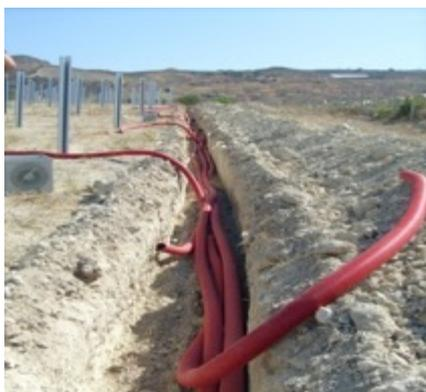
Il cavidotto avrà lo scopo di contenere i cavi che trasporteranno l'energia elettrica prodotta dalla centrale fotovoltaica al locale tecnico secondo il tracciato previsto.
