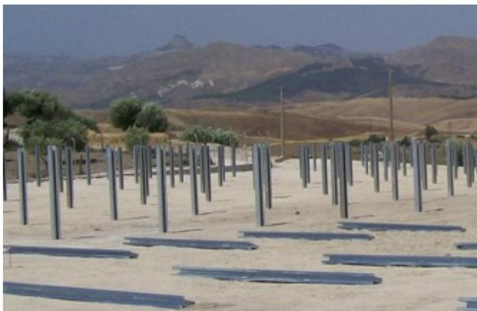
La scelta progettuale della tipologia di fondazione è stata dettata sia dalle caratteristiche morfologiche e geologiche del sito di installazione sia dalla flessibilità di installazione. Morfologicamente il territorio è pianeggiante, con caratteristiche geotecniche idonee a garantire la fattibilità del progetto.
