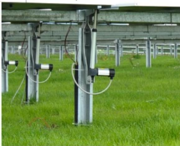
L'utilizzo di questo tipo di sostegni consente un'esposizione ottimale dei pannelli fotovoltaici all'irraggiamento solare grazie alla scelta della struttura che sarà ad inseguimento monoassiale e quindi una maggiore produzione per superficie captante ed occupata in quanto il software **ottimizza l'angolo di inclinazione dei**
