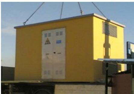
Tutte le cabine sono realizzate in conformità alla normativa vigente sui manufatti in calcestruzzo armato vibrato: Legge 1086/71 - D.M. 3/12/87 - circolare n. 31104 del 16/03/89. I progetti sono depositati al Min. LLPP. I manufatti sono inoltre conformi alle norme CEI 11-1 e CEI EN 61330.
