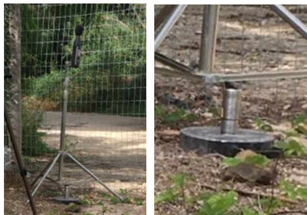
Figura 3-2 Esempio di installazione dell'accelerometro
