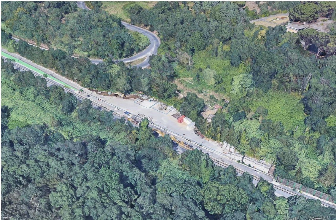
Figura 6-25 AT1-01_ Piazzale Bivio Pineto e sede per la realizzazione delle opere FA01 e FA02
