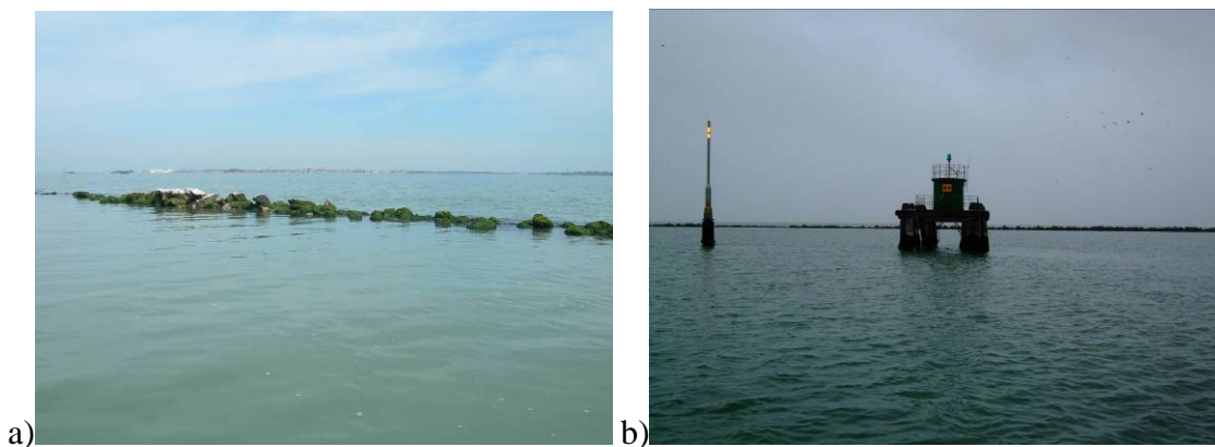
Figura 5-42 Presenza della linea di dighette a protezione dei bassifondi lagunari.
