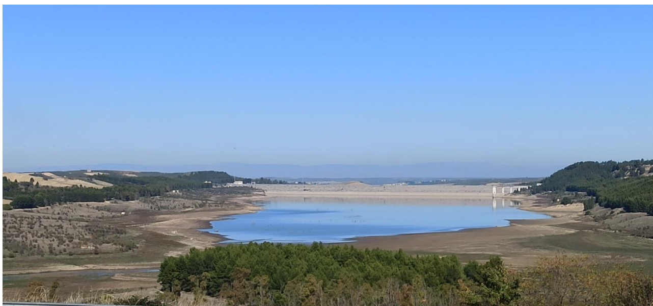
Figura 3 – Vista dell’invaso del Locone.
