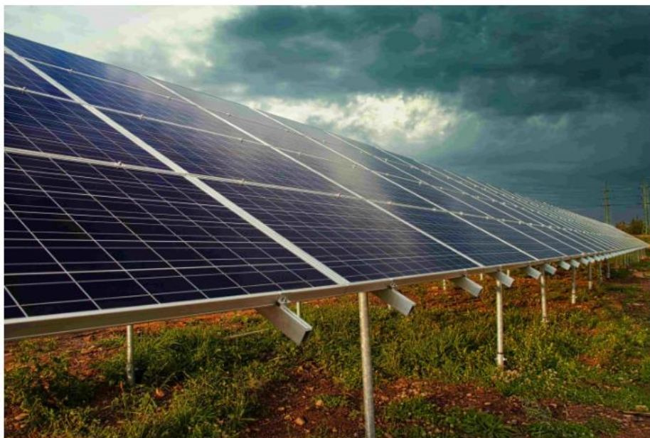
Fig. 01 _Esempio di tappeto erboso sotto le strutture dei moduli fotovoltaici
