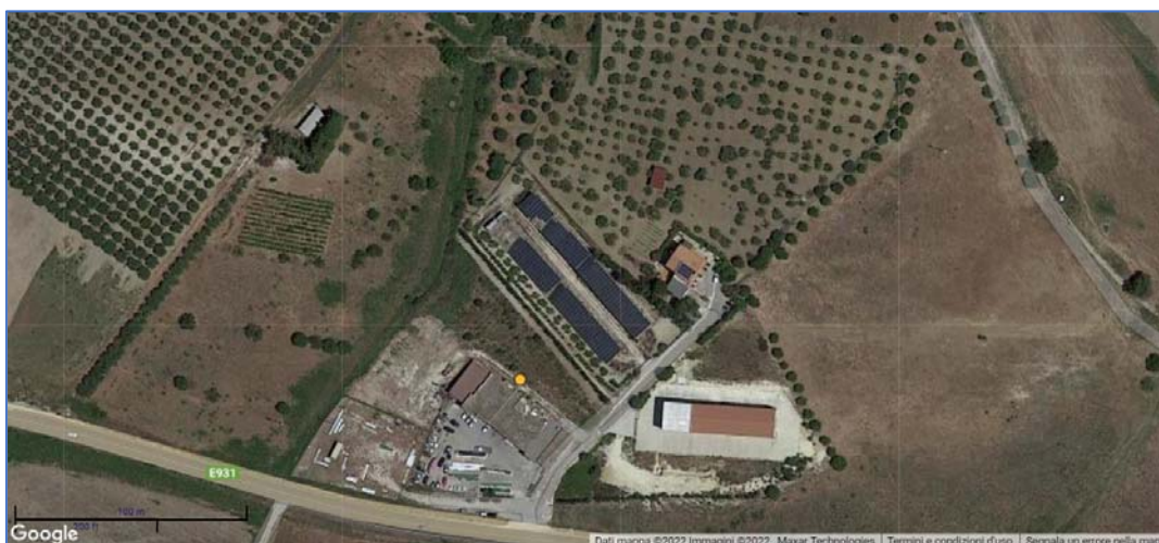
Fig. 18 _Immagine satellitare dell'impianto fotovoltaico a terra n. 2
