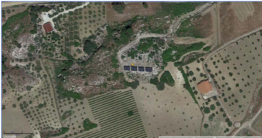
Fig. 17 _Immagine satellitare dell'impianto fotovoltaico a terra n. 1
