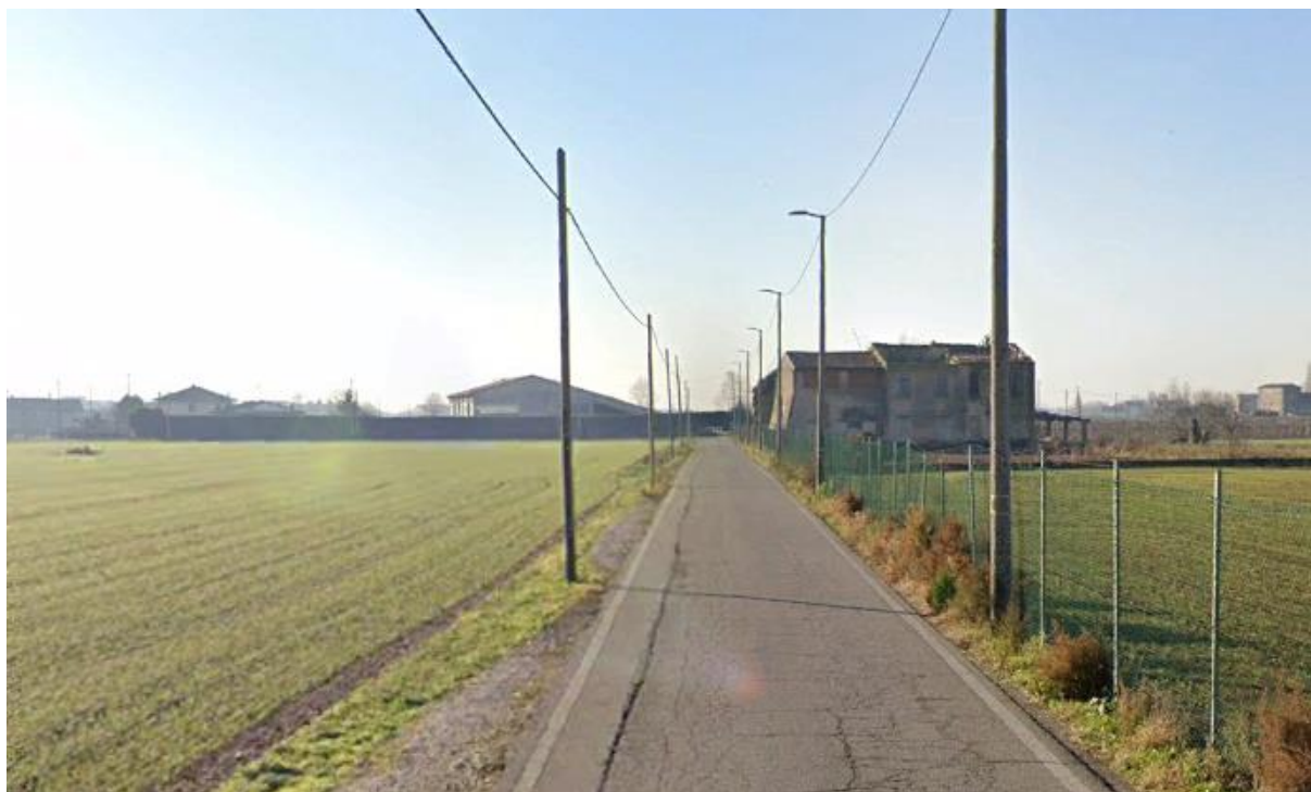
Fig.30-Stato pavimentazione viabilità secondaria
