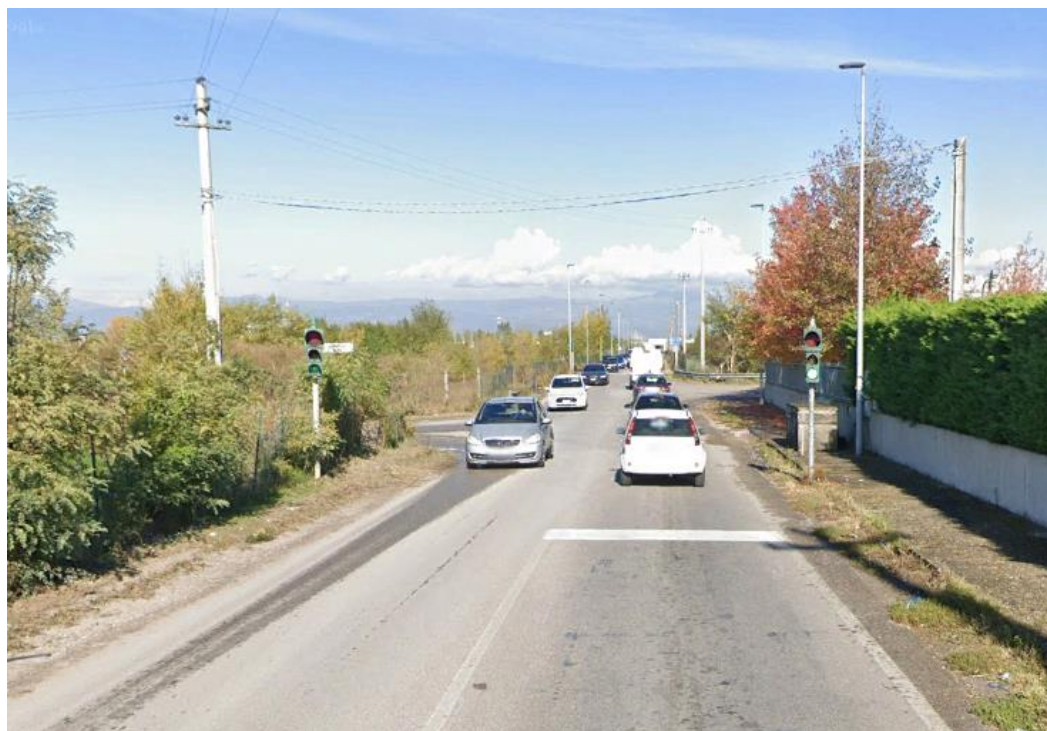
Fig.19-Intersezione Strada La Rizza-via Ca Brusà regolata da impianto semaforico
