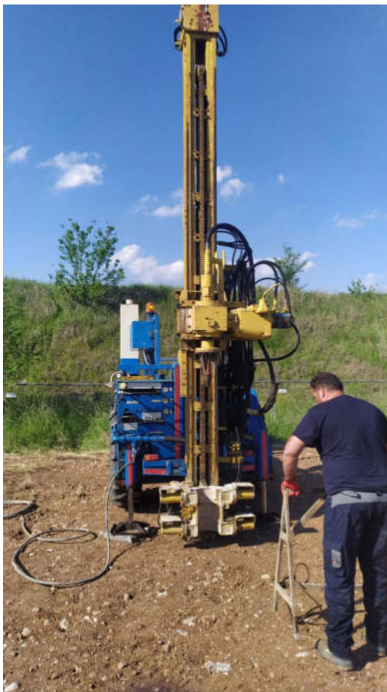
Figura 2 – Sonda approntata nel sondaggio S04
