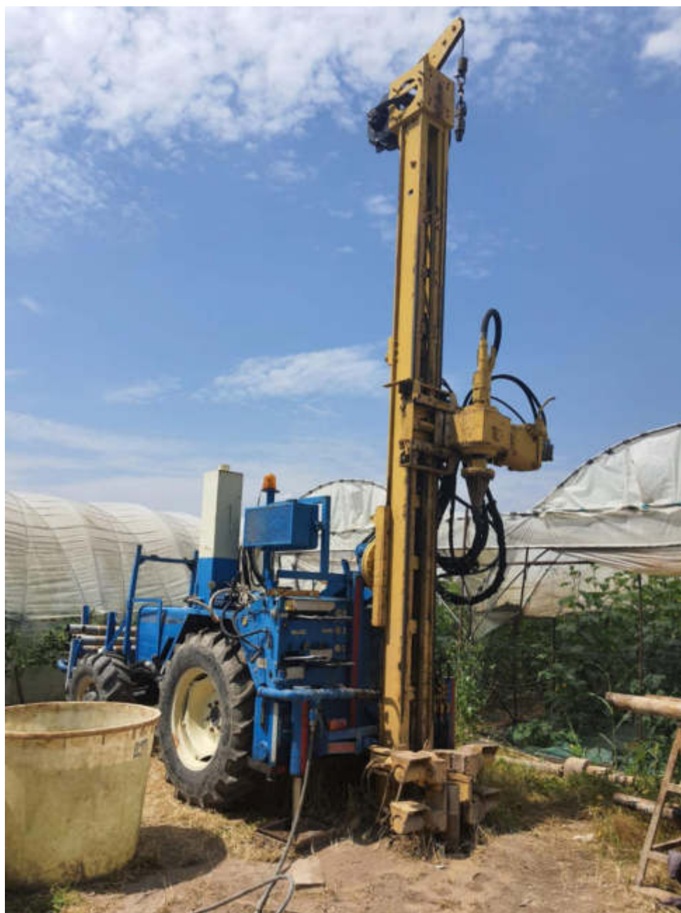
Figura 2 – Sonda approntata nel sondaggio S21
