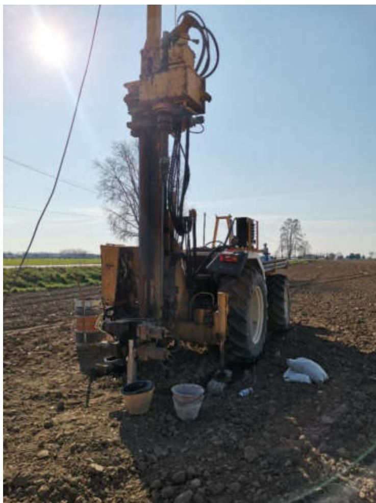
Figura 2 – Sonda approntata nel sondaggio S33_PZ
