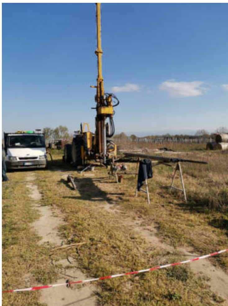
Figura 2 – Sonda approntata nel sondaggio S42_PZ
