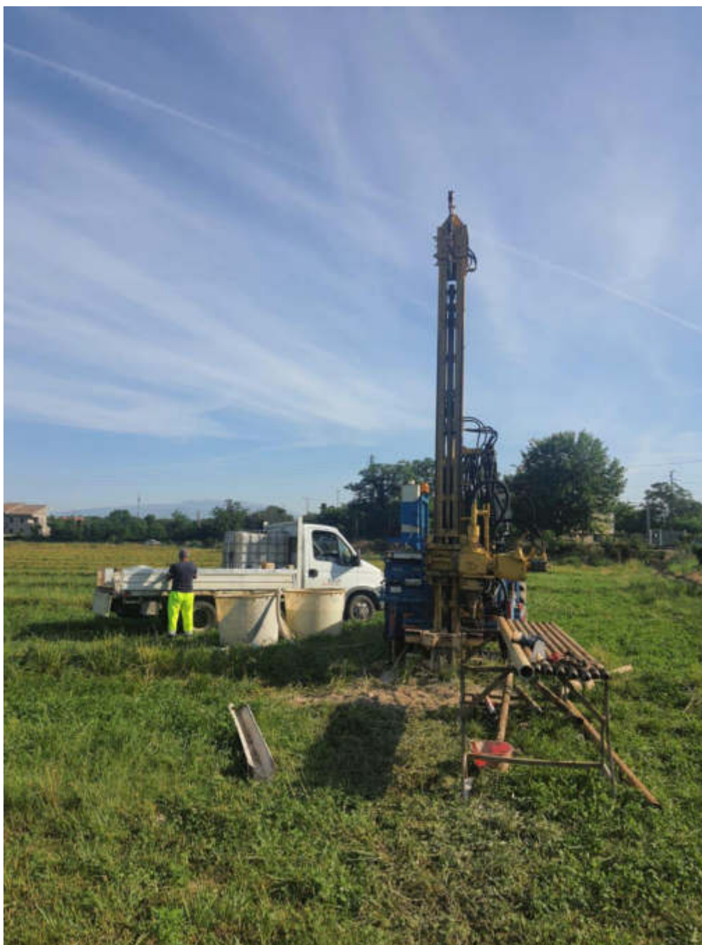
Figura 2 – Sonda approntata nel sondaggio S14_PZ
