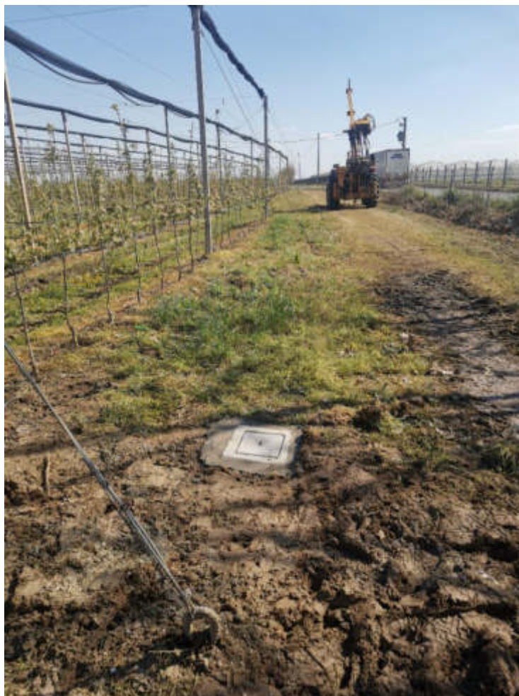
Figura 10 – Chiusino carrabile a protezione della strumentazione installata nel sondaggio S40_PZ.
