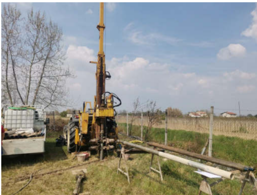
Figura 2 – Sonda approntata nel sondaggio S43
