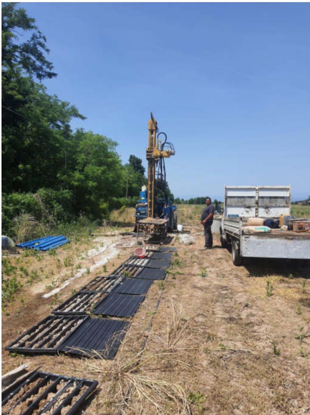
Figura 2 – Sonda approntata nel sondaggio S28
