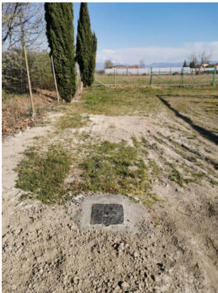
Figura 9 – Chiusino carrabile a protezione della strumentazione installata nel sondaggio S36_PZ.
