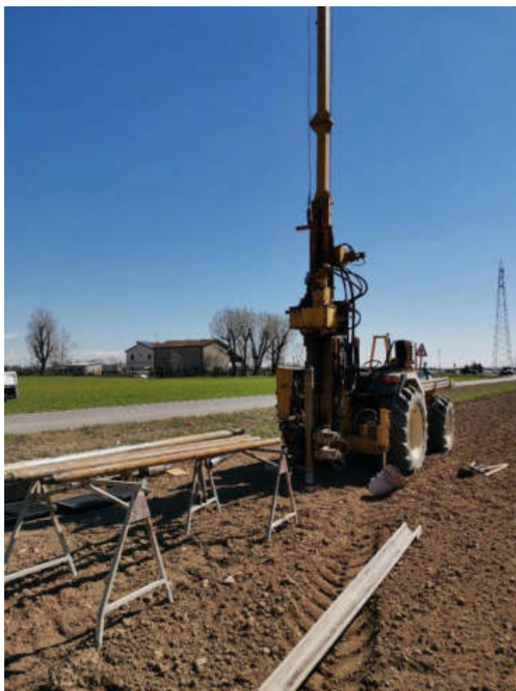
Figura 2 – Sonda approntata nel sondaggio S32_PZ
