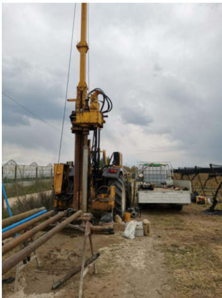
Figura 2 – Sonda approntata nel sondaggio S44_PZ
