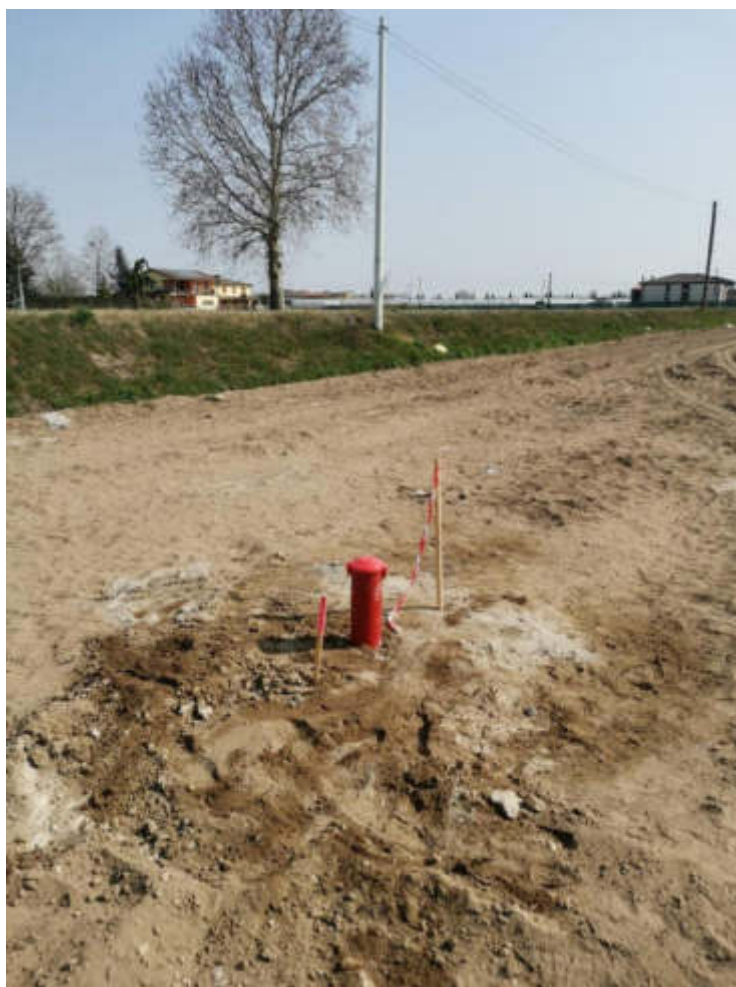
Figura 6 – Chiusino in PVC a protezione della strumentazione installata nel sondaggio S34_PZ.
