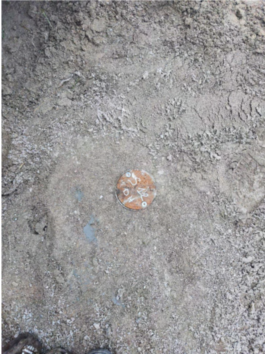
Figura 10 – Chiusino in cemento prefabbricato a protezione della strumentazione installata nel sondaggio S12_DH.
