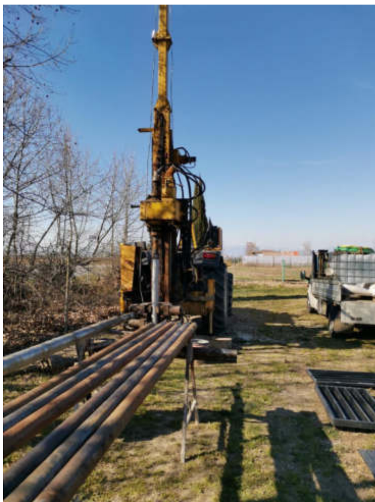
Figura 2 – Sonda approntata nel sondaggio S36_PZ
