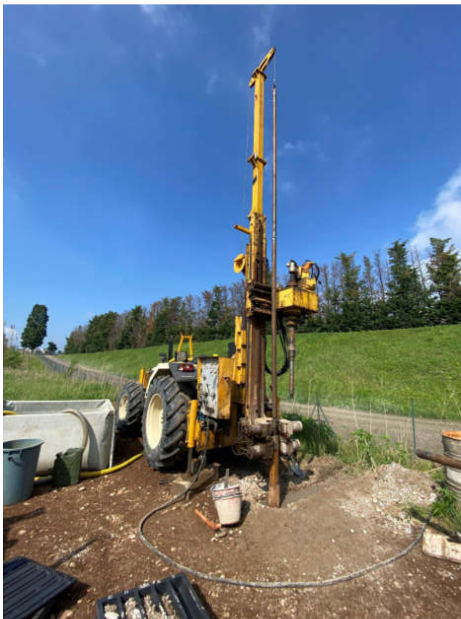
Figura 2 – Sonda approntata nel sondaggio S03
