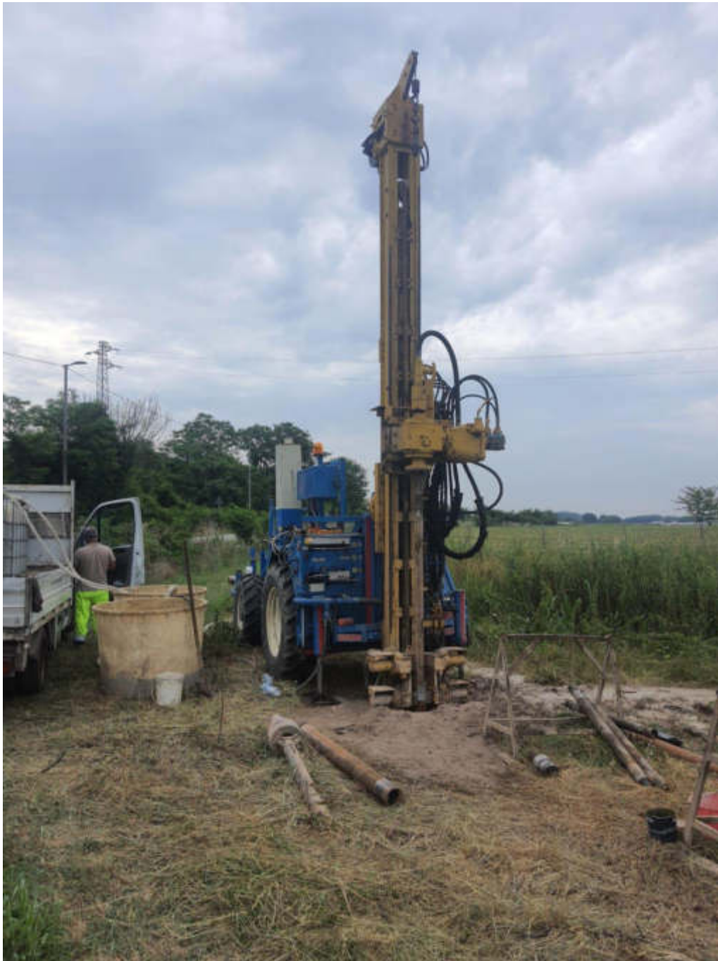
Figura 2 – Sonda approntata nel sondaggio S12_DH
