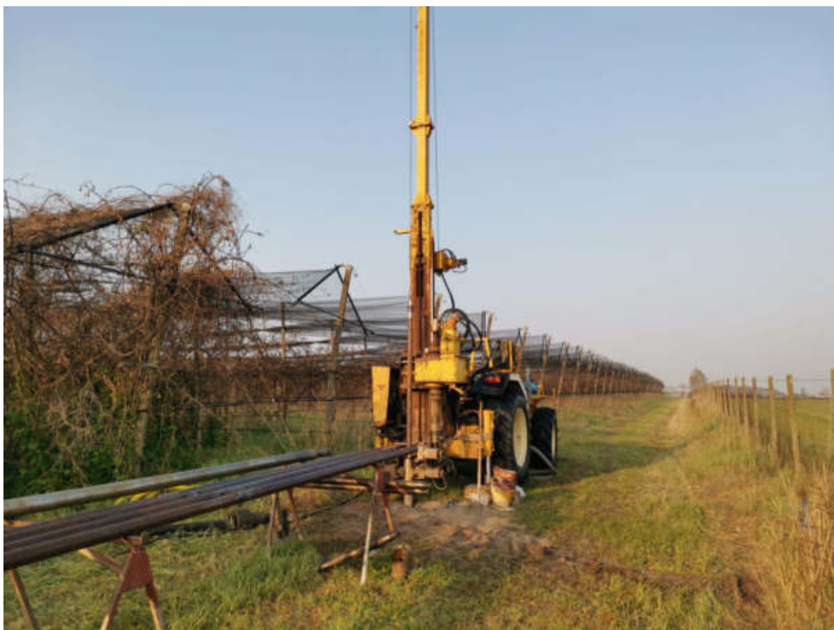
Figura 2 – Sonda approntata nel sondaggio S46
