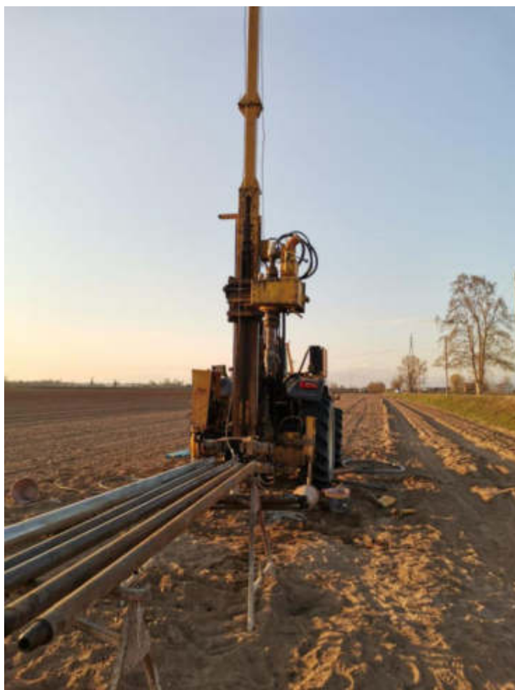
Figura 2 – Sonda approntata nel sondaggio S34_PZ
