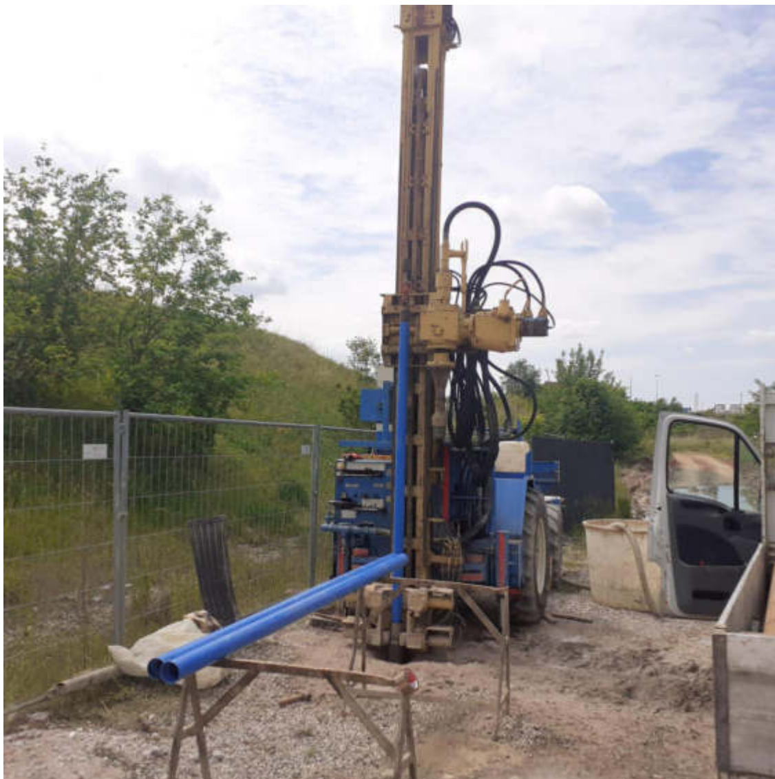
Figura 2 – Sonda approntata nel sondaggio S02
