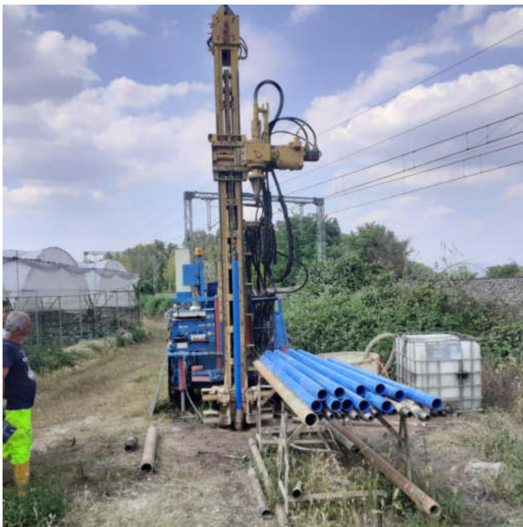
Figura 2 – Sonda approntata nel sondaggio S20
