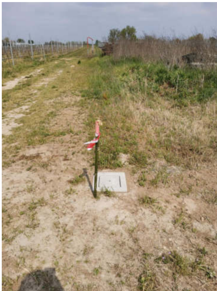
Figura 6 – Chiusino carrabile a protezione della strumentazione installata nel sondaggio S42_PZ.
