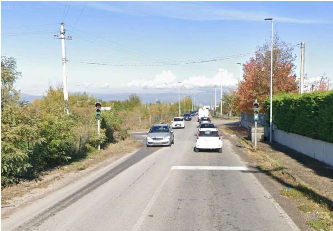
Intersezione Strada La Rizza-via Ca Brusà regolata da impianto semaforico
