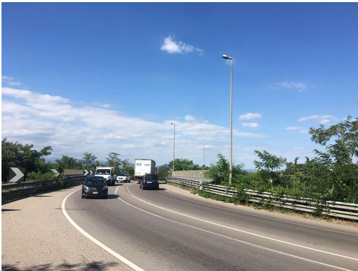
Cavalcaferrovia da demolire
