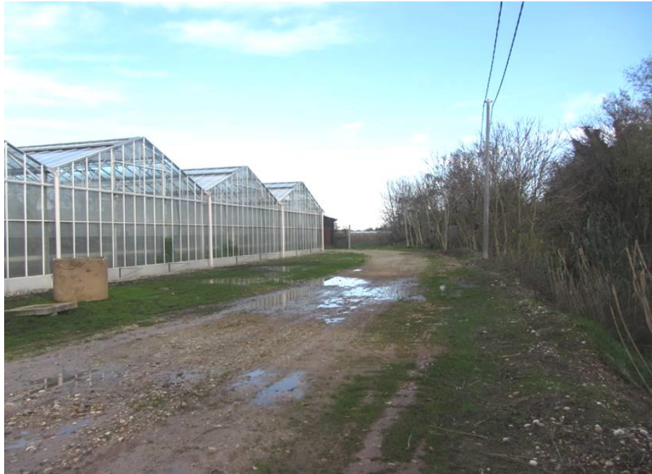
Fig. 2.81 - Capannoni di nuova costruzione in prossimità della risorgiva 115 (novembre 2013)
