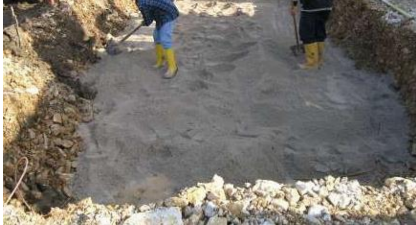
FIGURA 11 - SBANCAMENTO PIANO POSA CABINE
