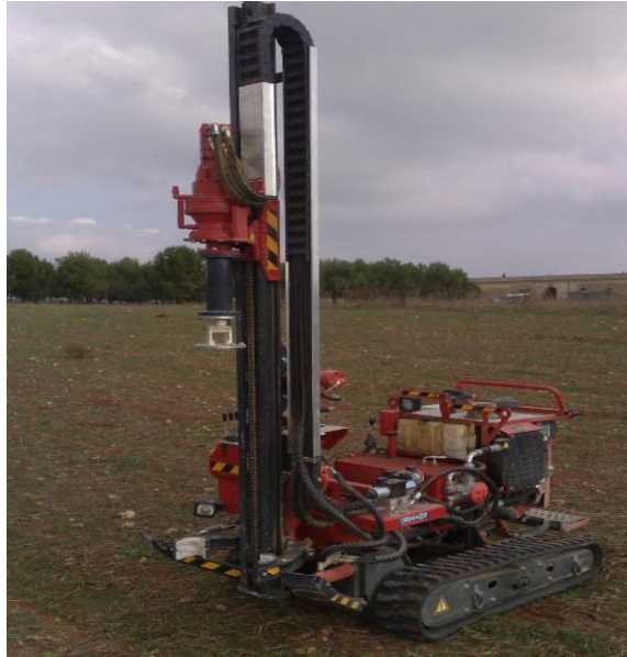
FIGURA 13 - MACCHINA BATTIPALO PER INFIESSIONE PALI.
