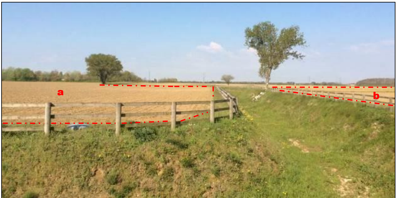
Foto 04: perimetro recintato della particella posto a margine del canale nella parte prossima all'incrocio con la viabilità interpodereale.
