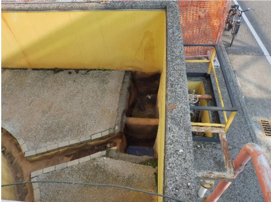
La tettoia di protezione pompe di caricamento insiste su una platea in cls dotata di cordoli di contenimento con pozzetto di raccolta e convogliamento alla fognatura oleosa.
