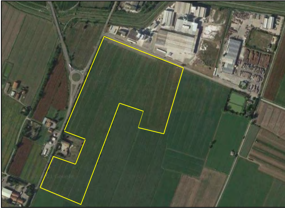
Figura 2 – Area oggetto di intervento
