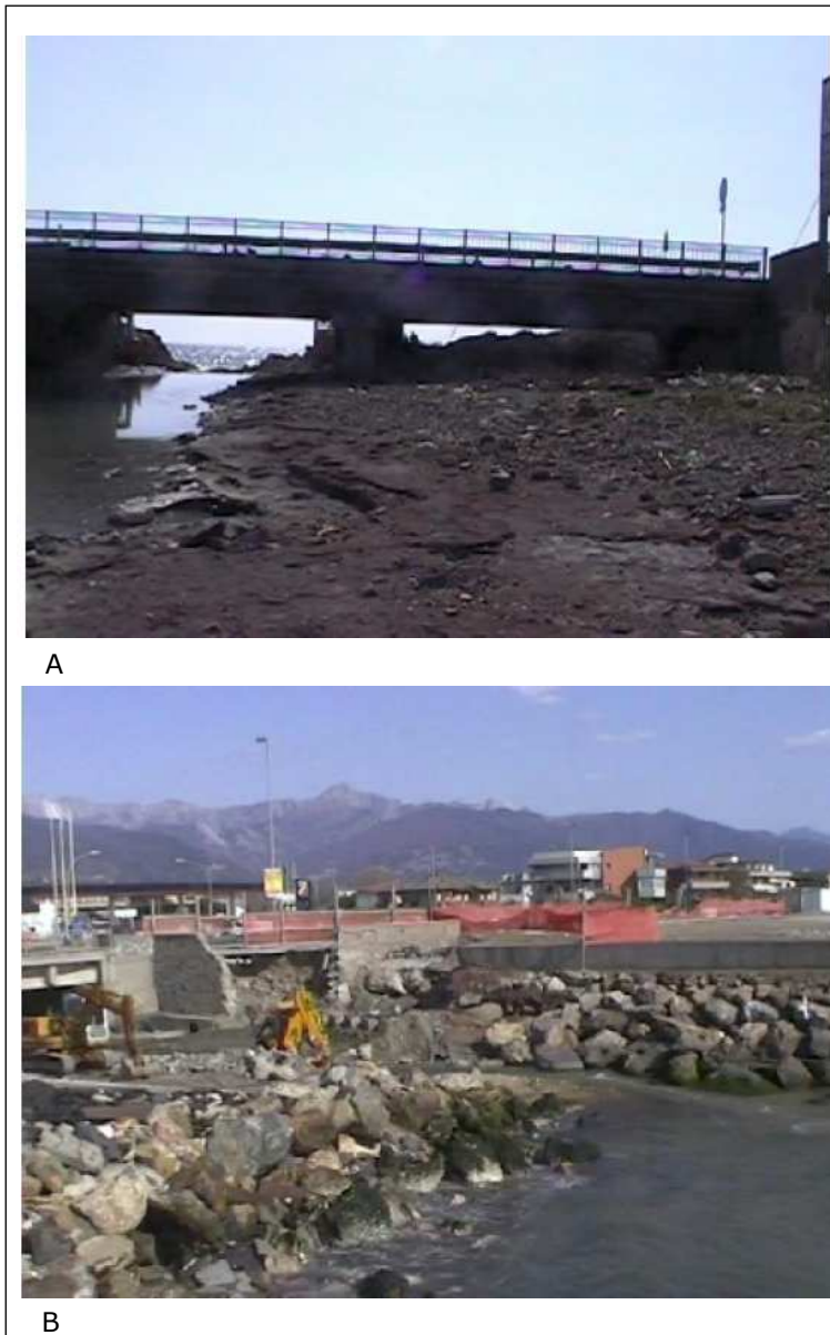
Figura C50 – A: vista del ponte stradale da monte; B: vista della sezione di foce
