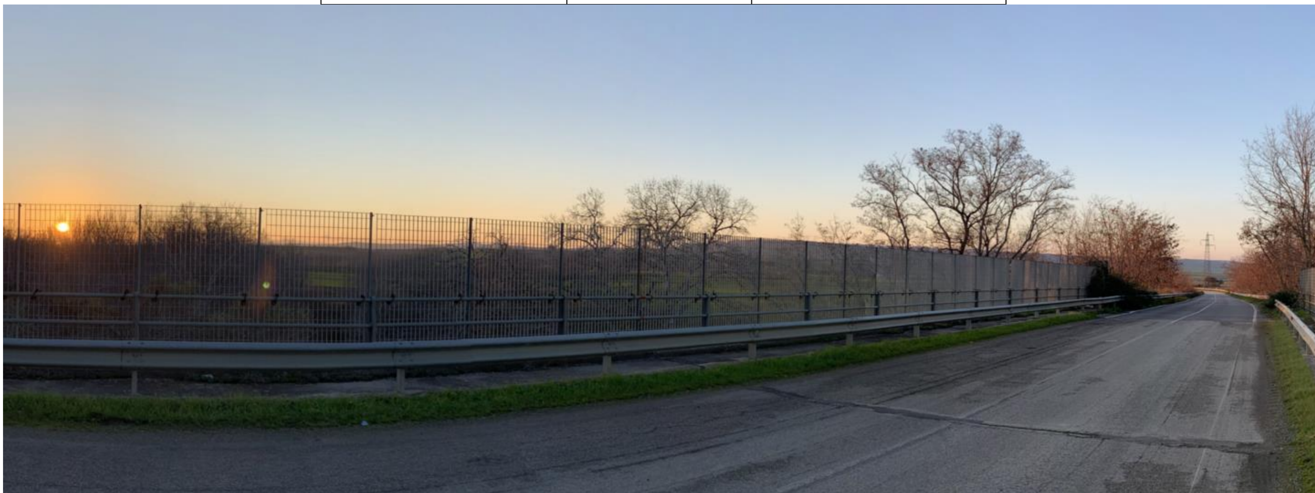
Figura 64: foto panoramica da PV 18: " SIC - VALLE FORTORE - LAGO DI OCHITO - S.P. 142 STRADA PANORAMICA", verso l'area di progetto
