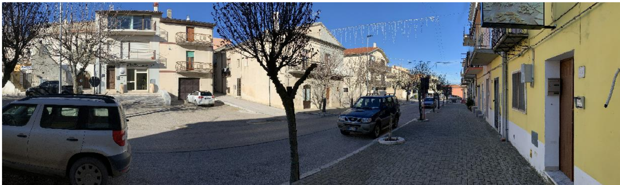
Figura 58: foto panoramica da PV 09: " CHIESA GRECA SANTA CROCE DI MAGLIANO", verso il centro dell'impianto
