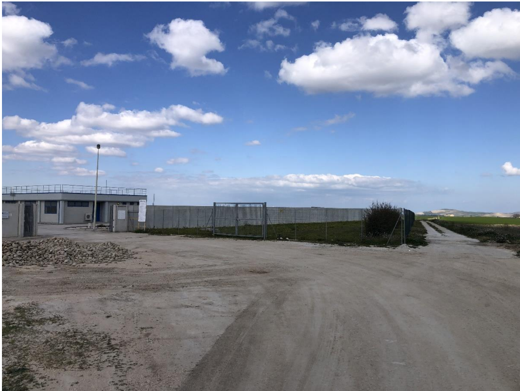
Figura 80: vista da N, dal segnaposto 16 - ingresso della sottostazione Terna con la strada poderale Piano della Fontana sulla destra
