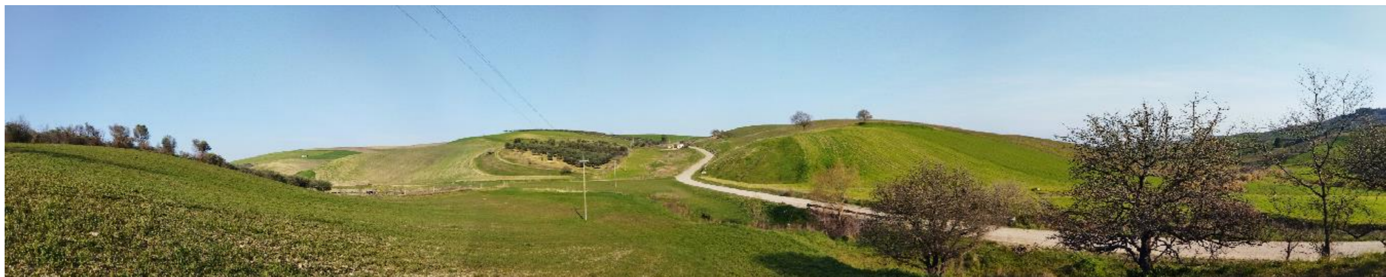
Figura 42: foto panoramica da PV f: tratto - Aquila - Foggia - vicino vallone Bivento, verso il centro dell'impianto
