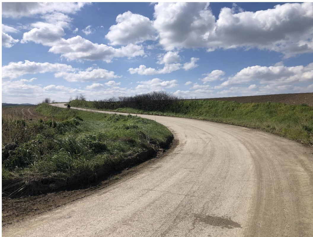
Figura 66: vista NE, dal segnaposto 1 - tratto della SP 167
