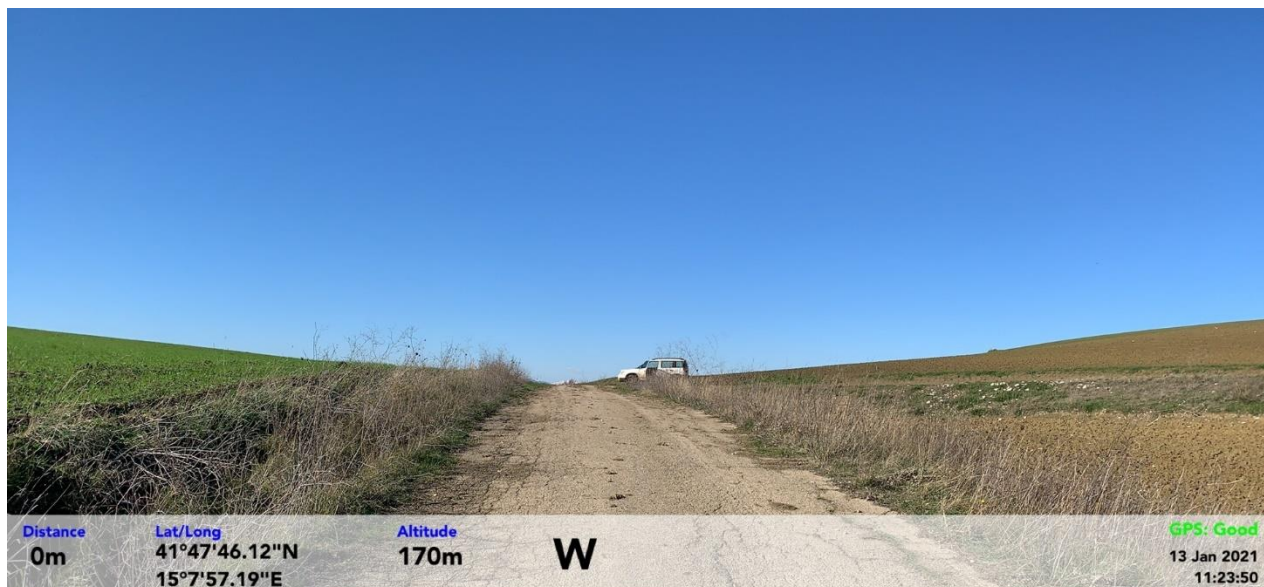
Figura 5: Da punto 030 verso accesso sterrato a WTG1
