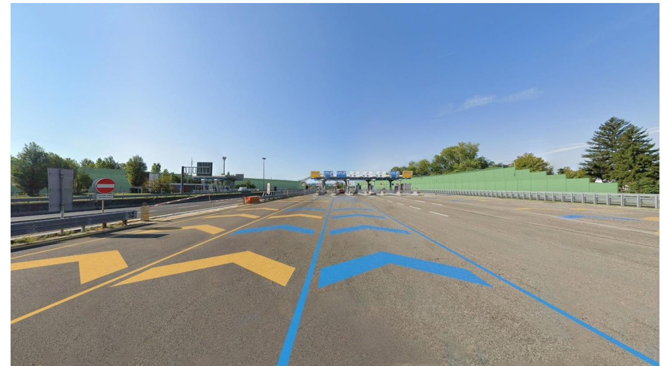
Figura 6-10 - (PV05) stato post operam – Attuale barriera di esazione da adeguare
