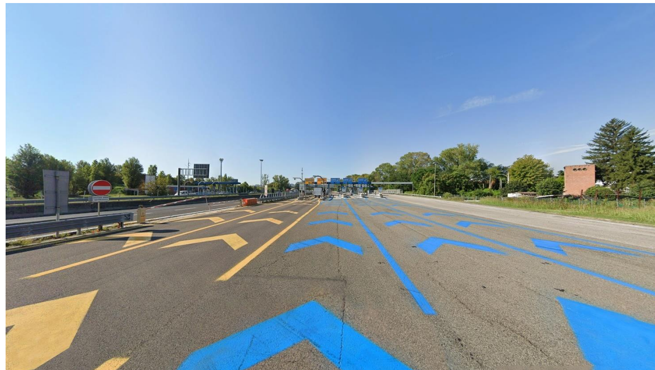
Figura 6-9 - (PV05) stato ante operam – Attuale barriera di esazione da adeguare
