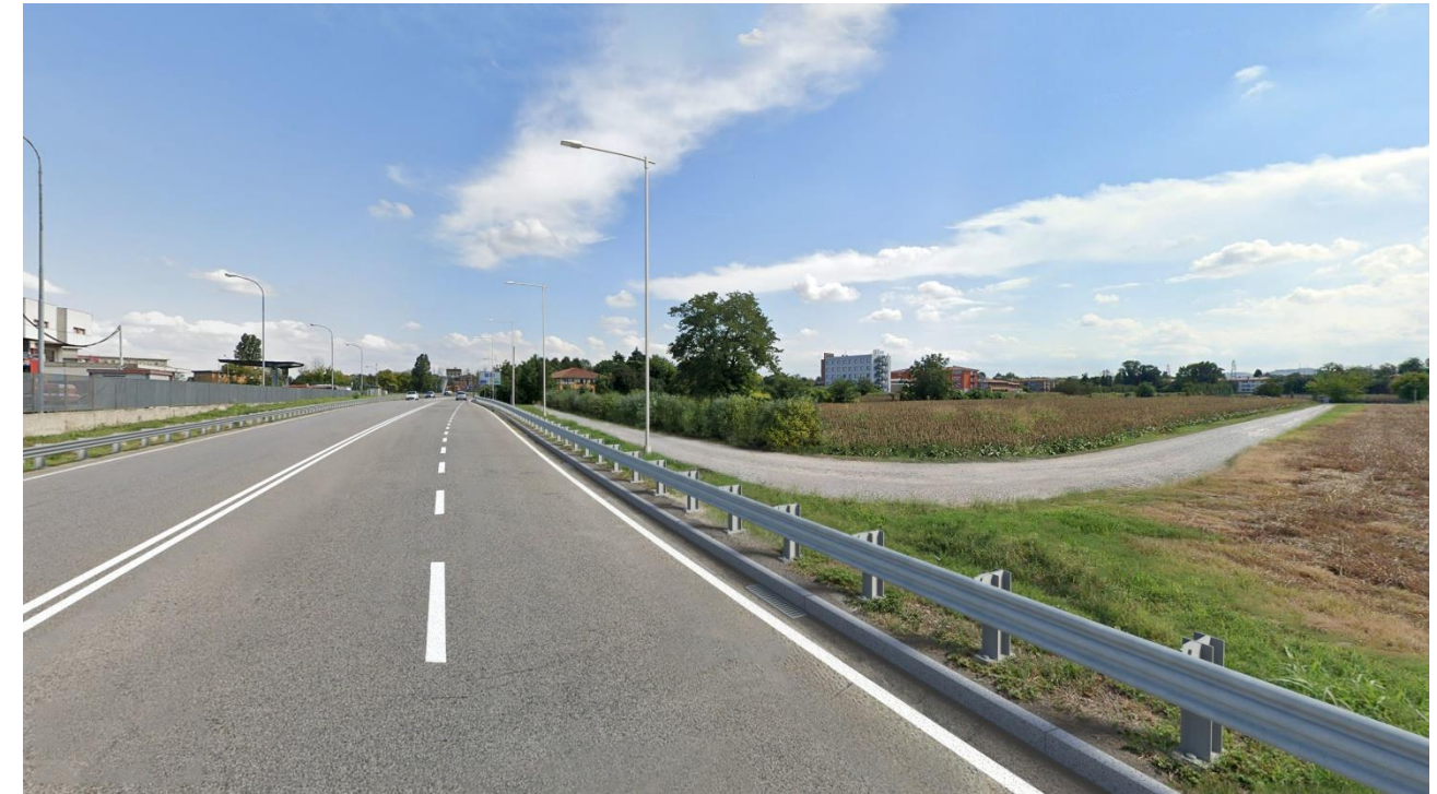
Figura 6-2 - (PV01) stato post operam – Via Aposazza
