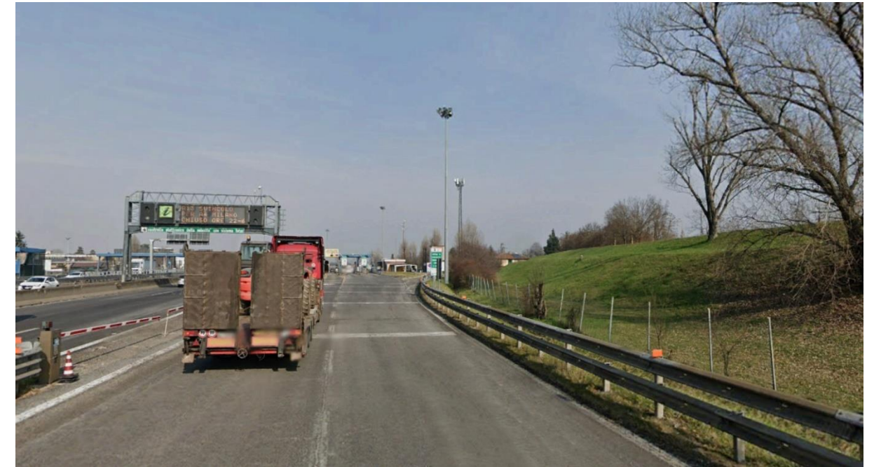
Figura 4-13 - Bacino di visibilità n.5 verso barriera di esazione esistente A13 Bologna Arcoveggio corsie est
