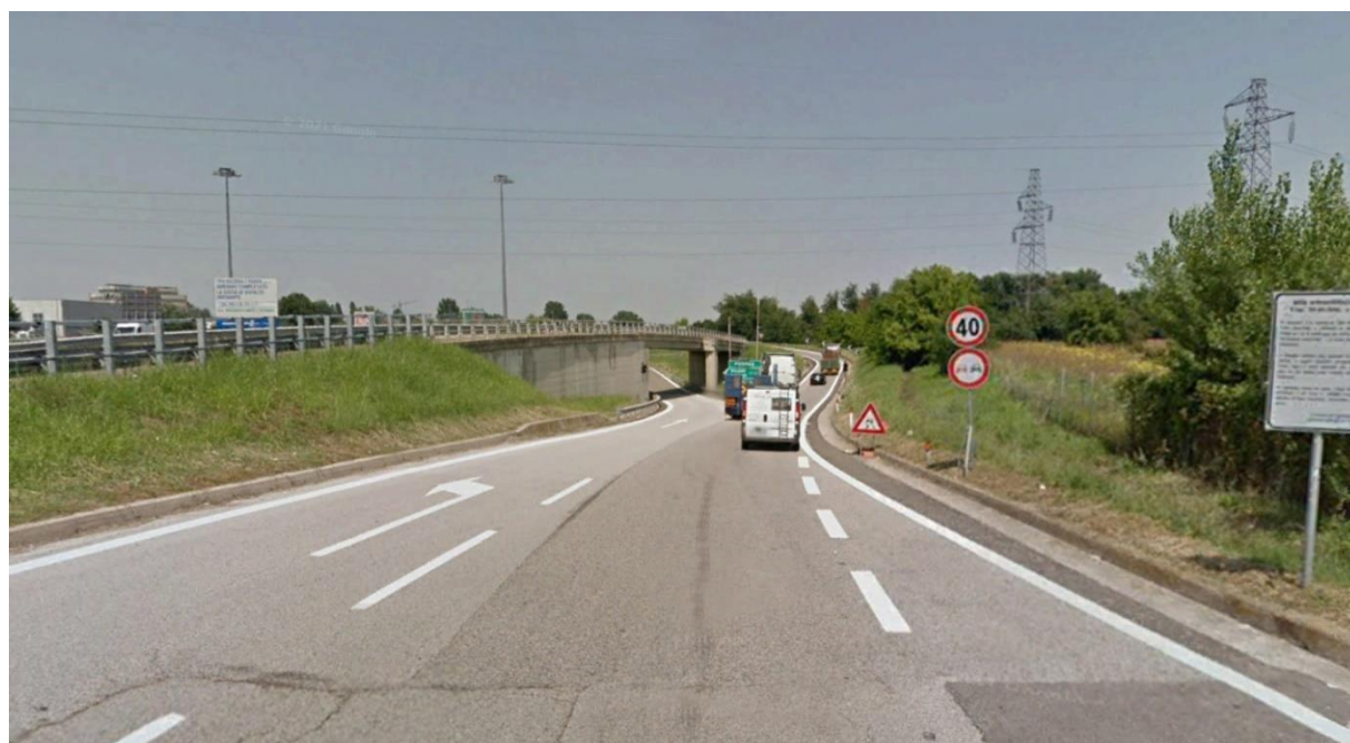
Figura 4-16 - Bacino di visibilità n.8 complanare est_ asse RS001
