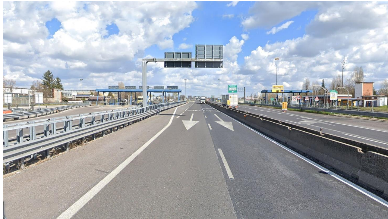
Figura 6-3 - (PV02) stato ante operam – Asse stradale A13
