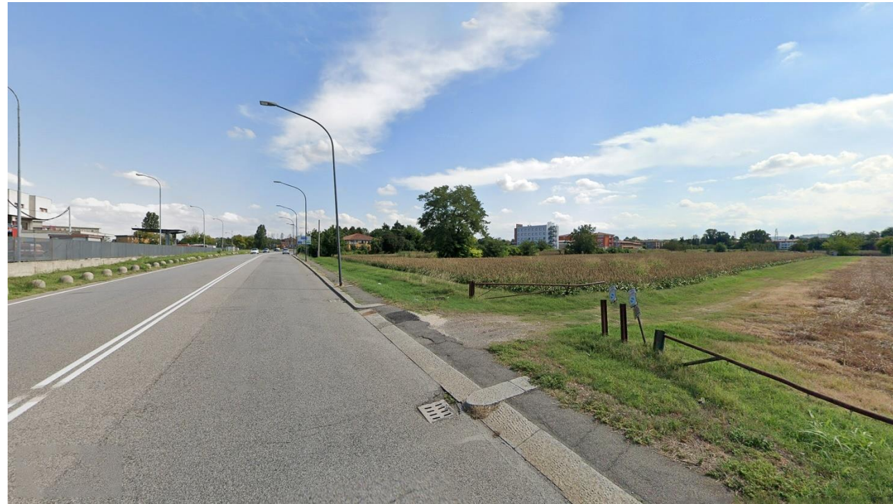
Figura 6-1 - (PV01) stato ante operam – Via Aposazza
