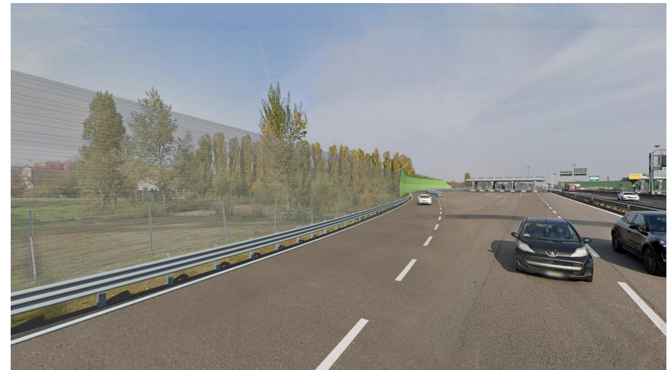
Figura 6-6 - (PV03) stato post operam – Area boschiva BO_0002 (in grigio in primo piano la barriera acustica prevista per il Passante, non oggetto di questo intervento)
