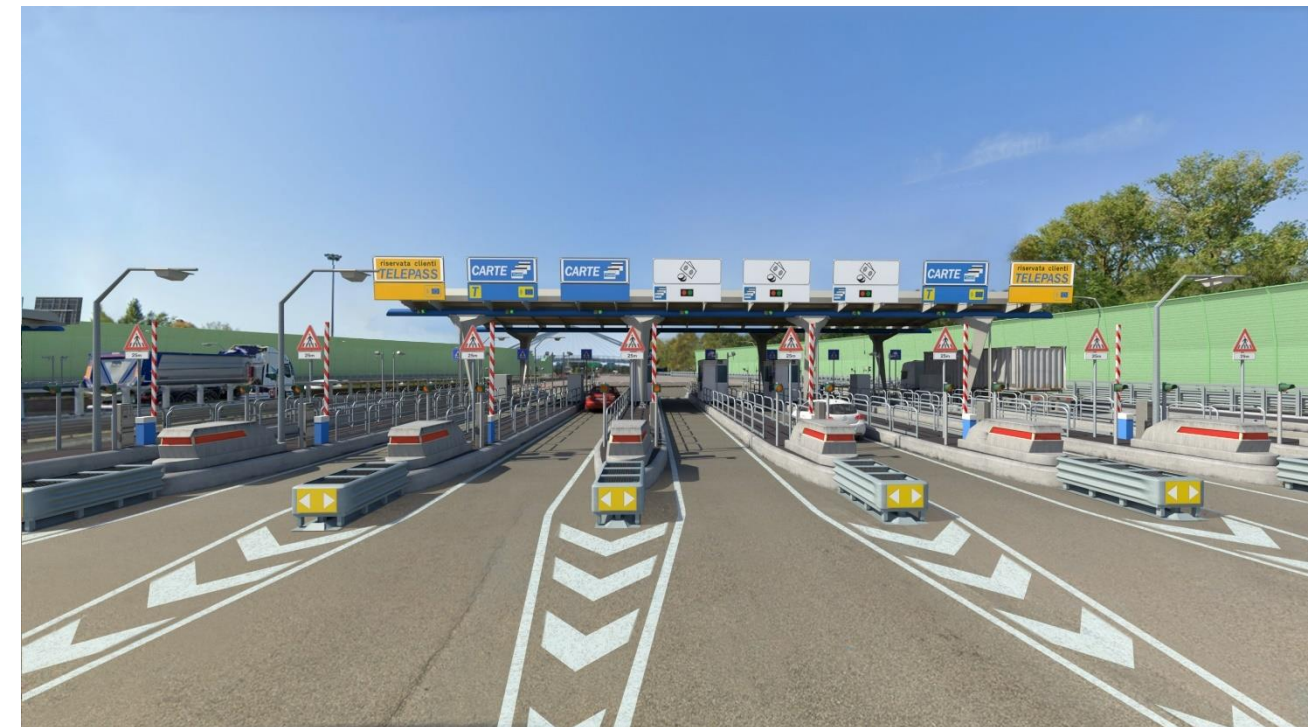
Figura 6-8 - (PV04) stato post operam – La nuova barriera di esazione
