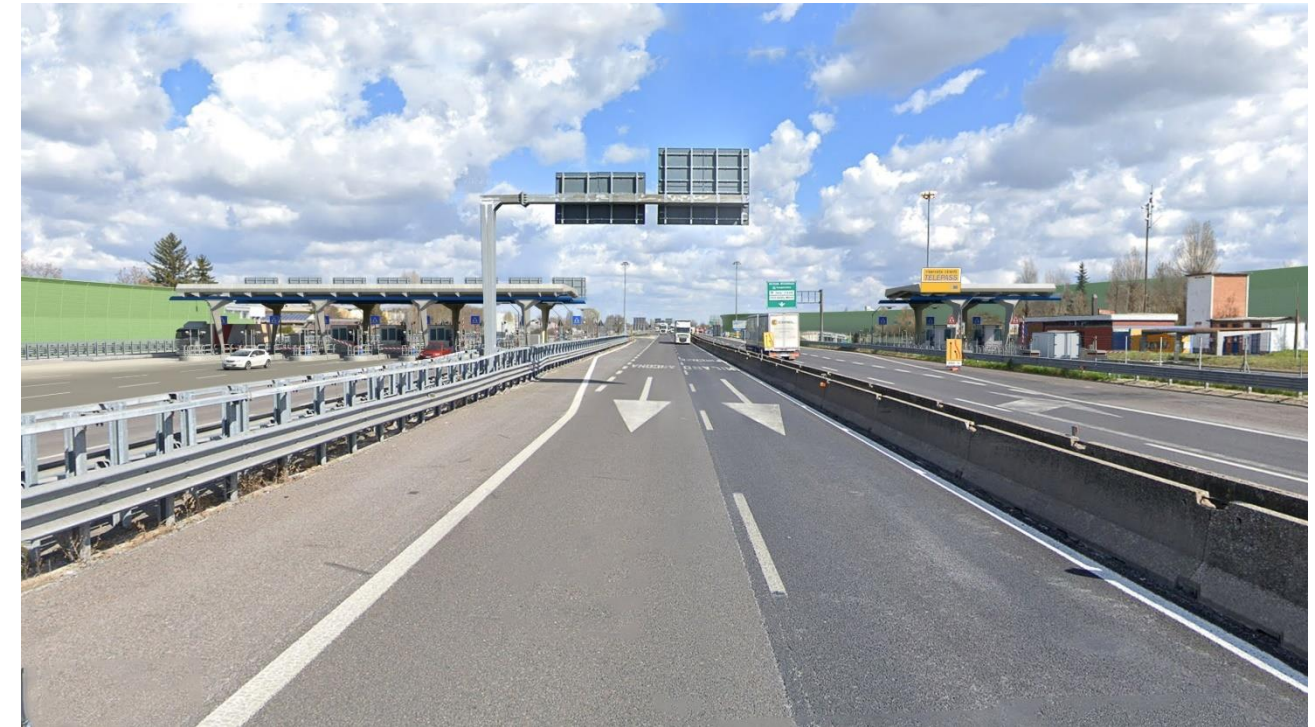
Figura 6-4 - (PV02) stato post operam – Asse stradale A13
