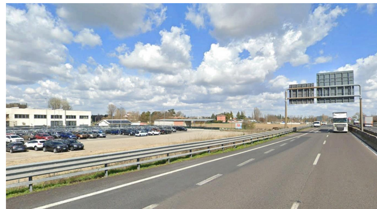
Figura 4-17 - Bacino di visibilità n.9 area rampa ovest asse RS006
