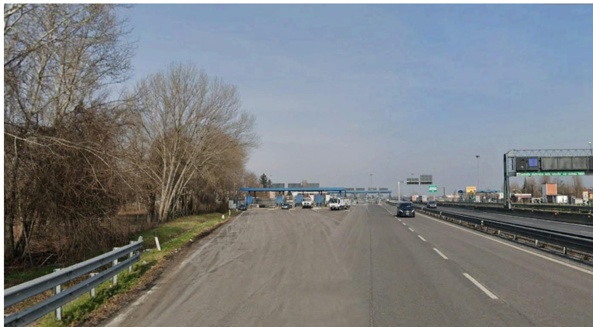
Figura 4-12 - Bacino di visibilità n.4 verso barriera di esazione esistente A13 Bologna Arcoveggio corsie ovest
