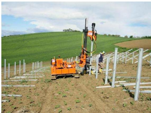
Figura 9 - Posa strutture metalliche di fondazione
