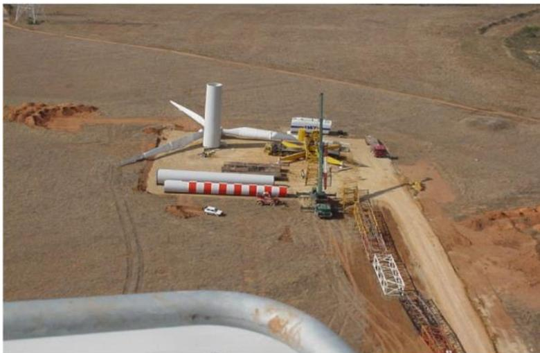
Figura 2 – Piazzola per il montaggio dell'aerogeneratore
