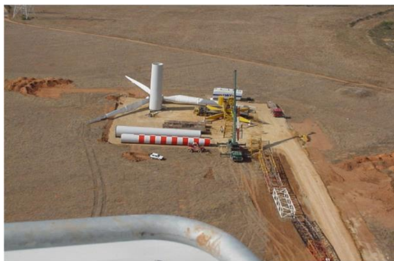
Figura 9 – Piazzola per il montaggio dell'aerogeneratore
