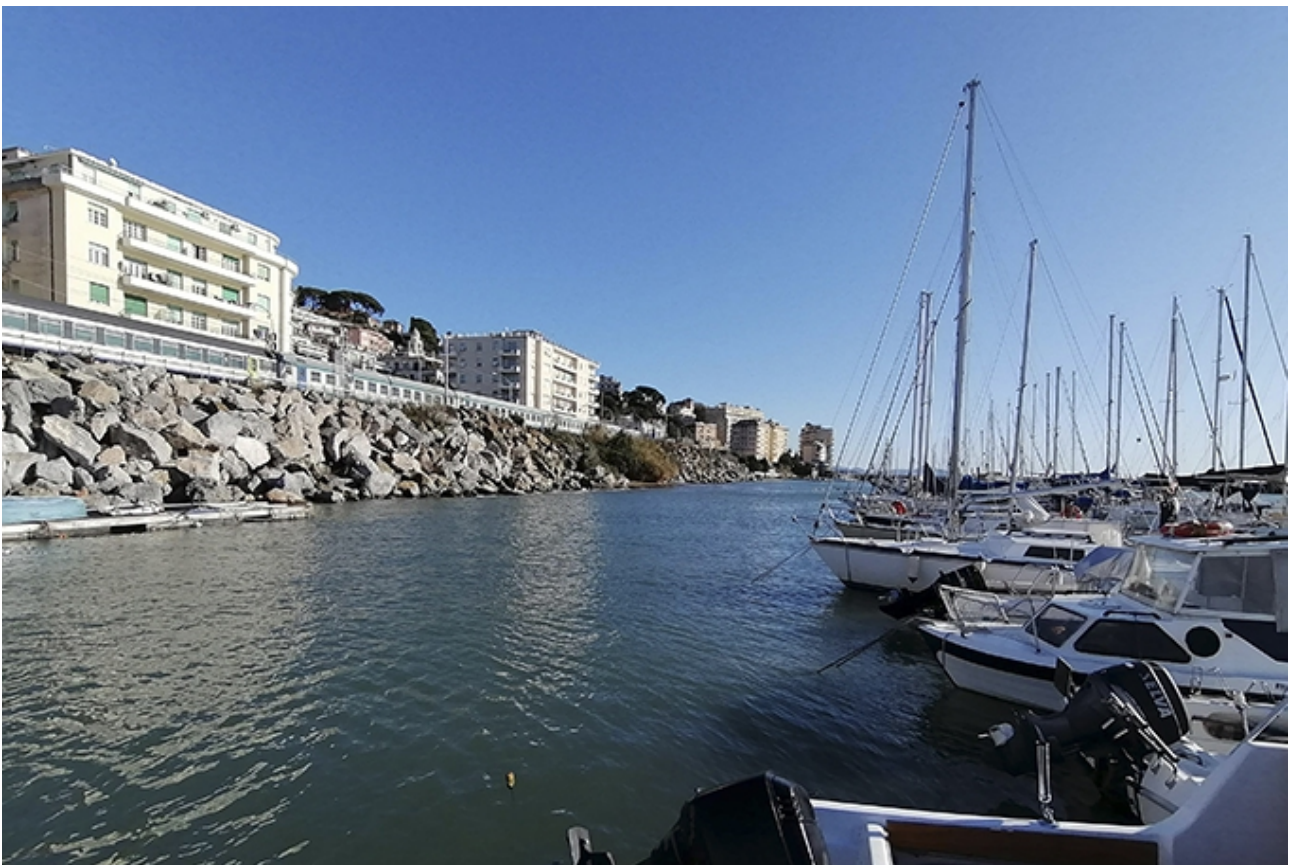
Il paraggio, dettaglio della massicciata ferroviaria verso il promontorio de Il Risveglio
