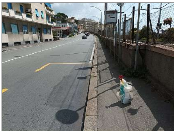
Foto 13: prova sismica passiva S_p (13).
