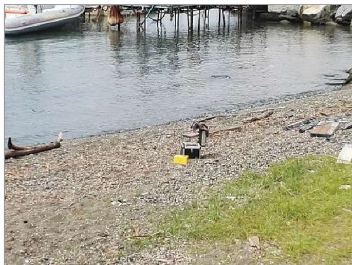
Foto 10: prova sismica passiva S_p (10).
