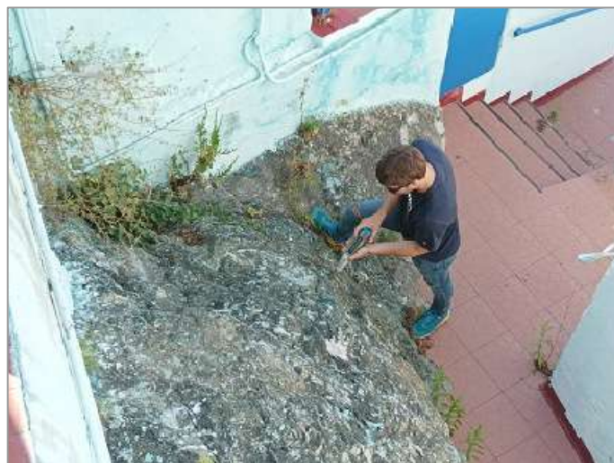
Foto 16: prove con sclerometro Stazione 2 .
