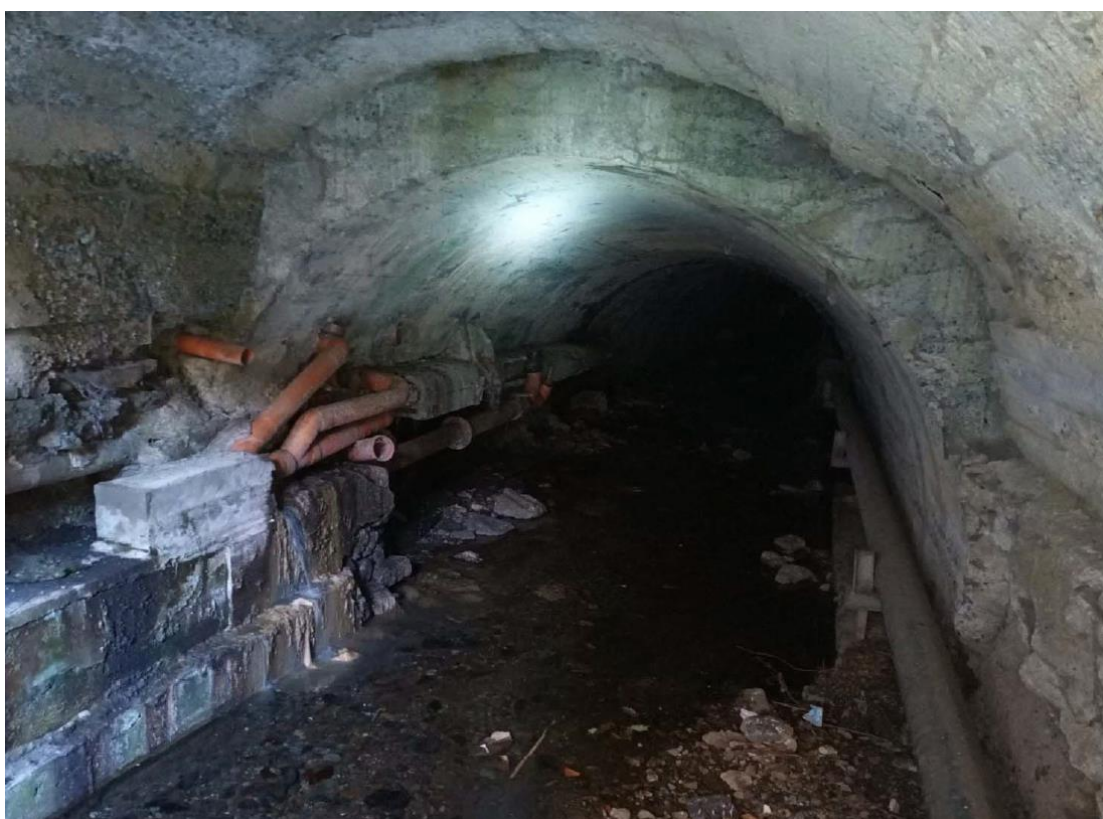
Figura 21 – Restringimento ed ingresso nel tratto tombinato – SEZ.17
