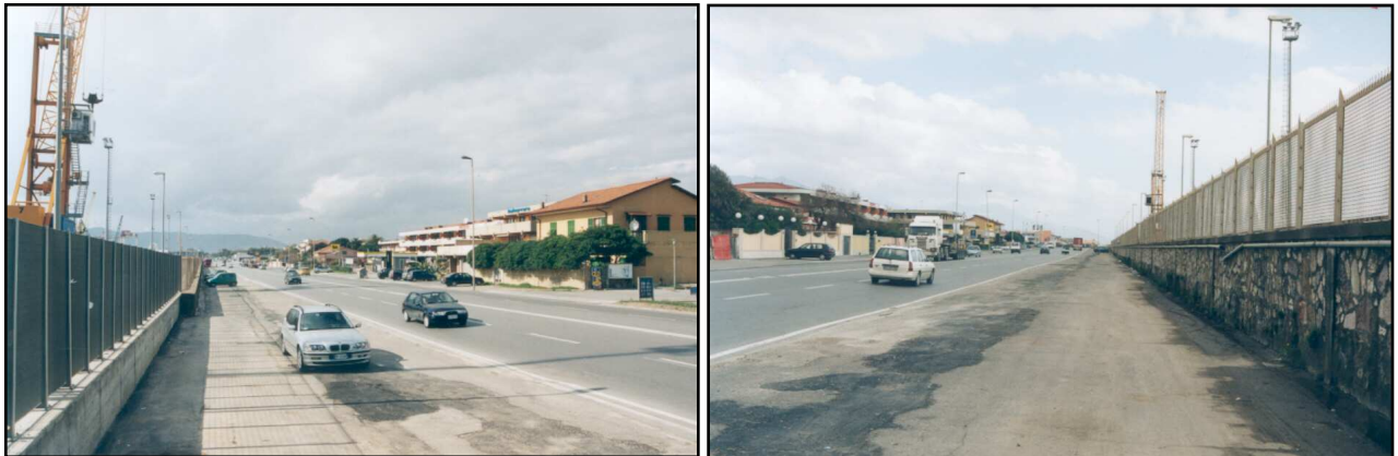
Figura C150 – Percezione dell’infrastruttura portuale da Viale da Verrazzano
